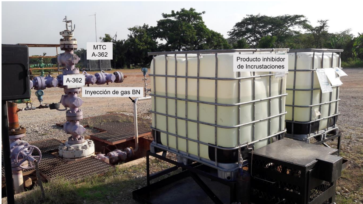
Figura 18. Bombeo neumático asistido con MTC a boca de pozo.
