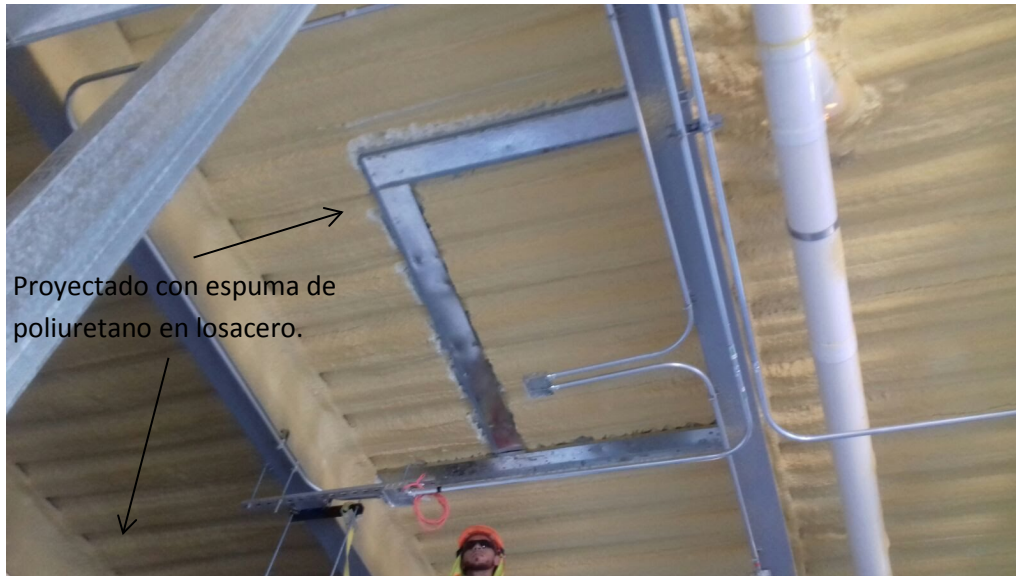
Imagen 6.- Proyectado térmico realizado con espuma de poliuretano en edificio Student Union, Campus Querétaro.
