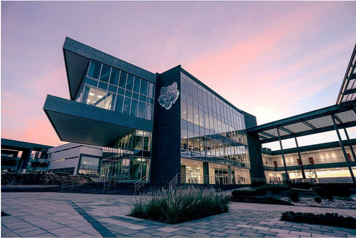
Imagen 19.- Edificio Student Union y al fondo Edificio Classrooms & Labs.
