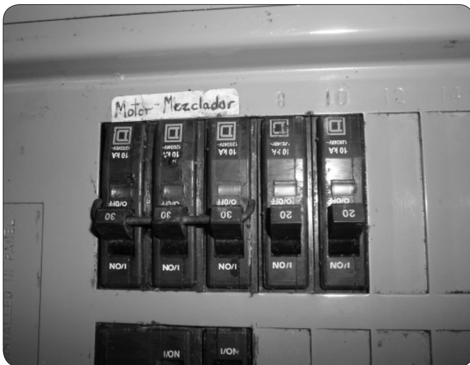
Figura 2.15 Las tres pastillas unidas por un alambre de aluminio de la parte superior que activan el motor del reactor anaerobio R-I
