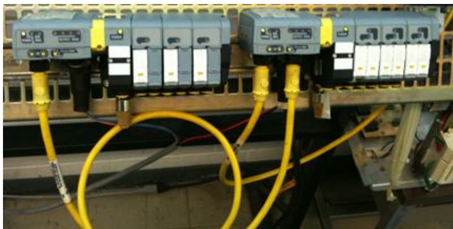
Figura 2.12. Módulos de electroválvulas monoestables (izquierda) y biestables (derecha).
