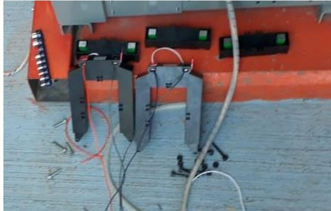
**Figura 4.2** Instalación de TC's
