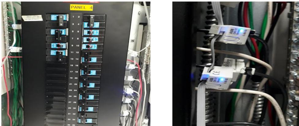
**Figura 4.5** a) Tablero eléctrico de servidores, con varios sensores BCM, b) Sensores BCM monitoreando cargas
