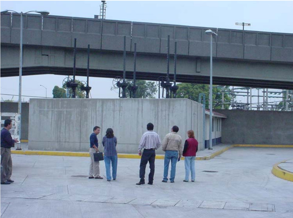
Foto 8 Visita a la planta de bombeo Zaragoza
