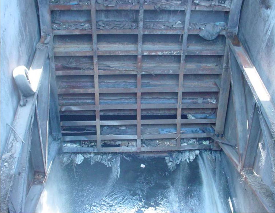
Fotos 29 y 30 Obra de toma del gran canal
