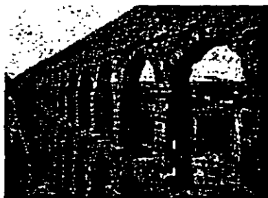
Figura 1.1. Acueducto de Segovia construido en el siglo de Augusto. Estas construcciones se hacían con el fin de conducir el agua necesaria para menesteres diarios. El aquí reproducido tiene una altura máxima de 31 metros y sus similares están sobrepuestos, sin mortero que los una.
