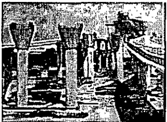
Pilas de puentes
