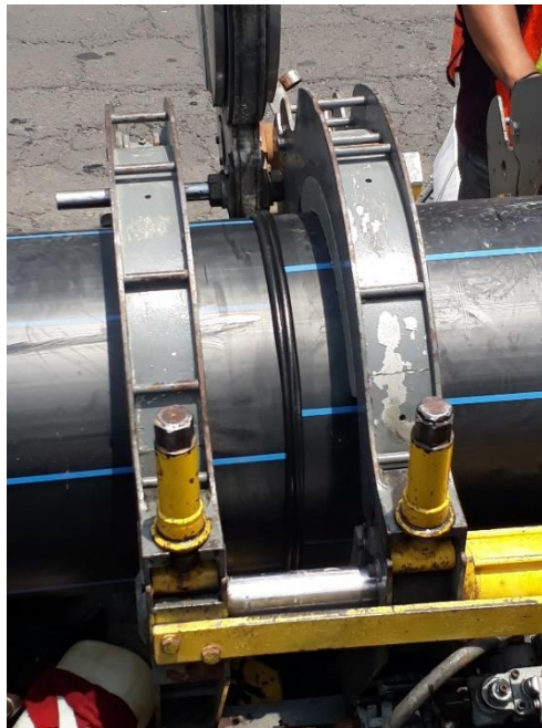
Imagen 23, unión de extremos de tubería calentados para así obtener la termofusión de la tubería.
