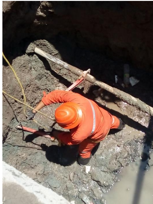
Imagen 52, retiro de punta para perforación piloto y colocación de puntas para retroensanchados 2 .
