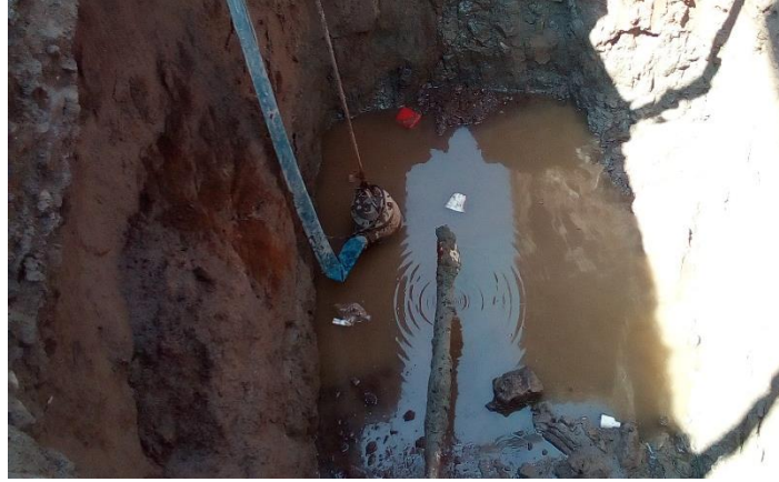
Imagen 44, bombeo de achique con equipo tipo becerro de 3 ra 2.
