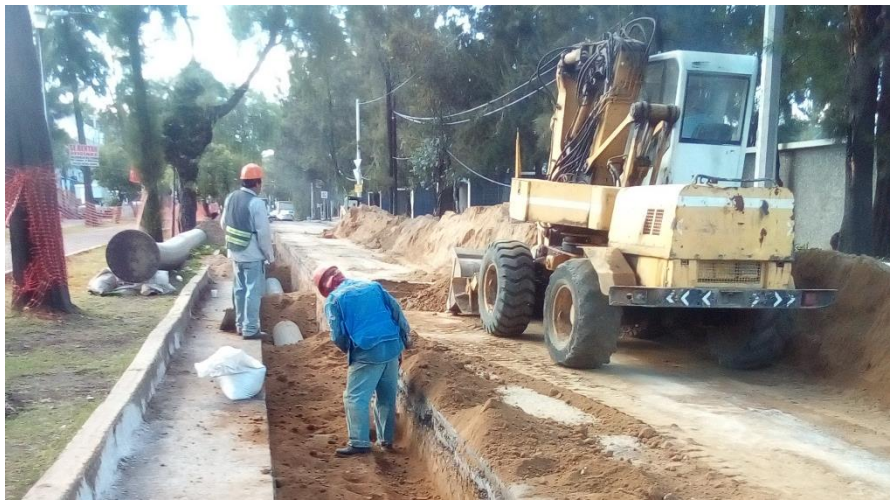
Imagen 29, relleno y compactado en zanja 2 .
