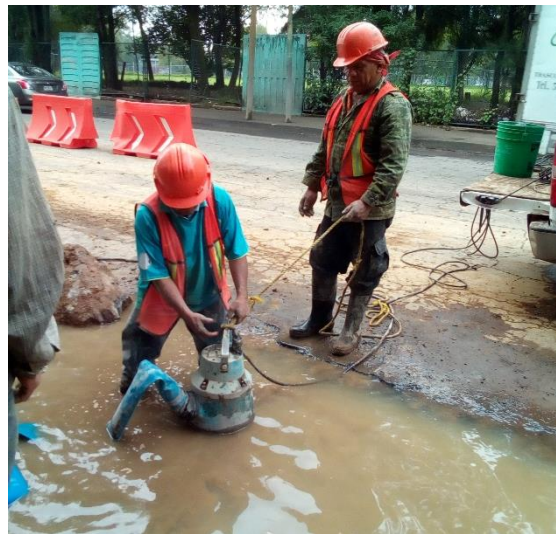
Imagen 18, utilización de equipo de bombeo tipo “becerro de 3 in” 2 .
