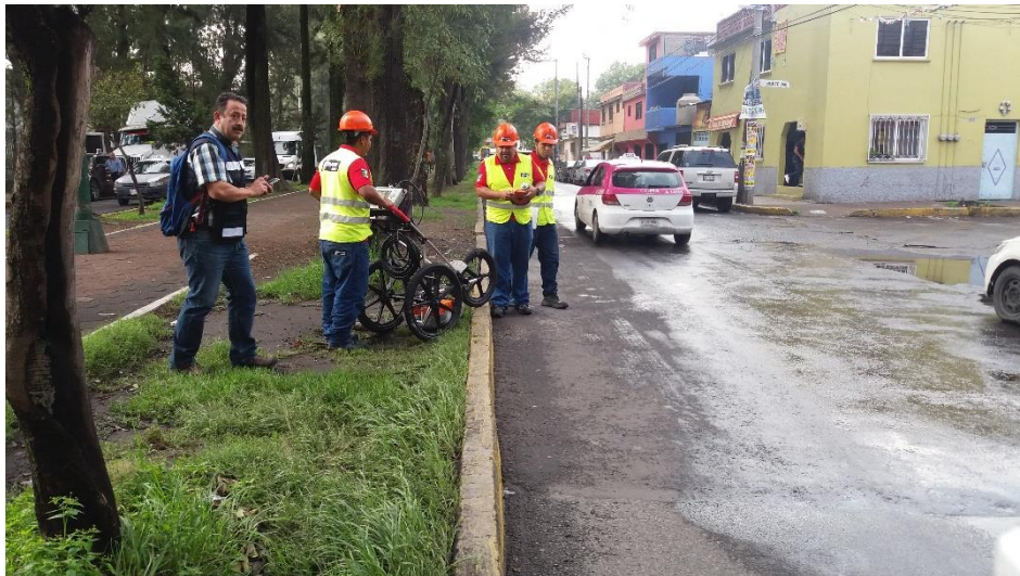
Imagen 12, uso de Georadar para identificación de interferencias 2 .
