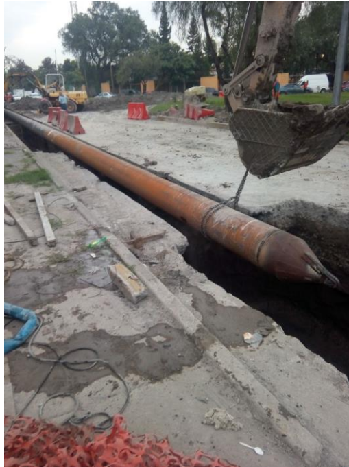
Imagen 57, colocación de tubería de acero dentro de la excavación adicional para posicionarla de manera horizontal y al mismo nivel de la perforación direccional 2 .
