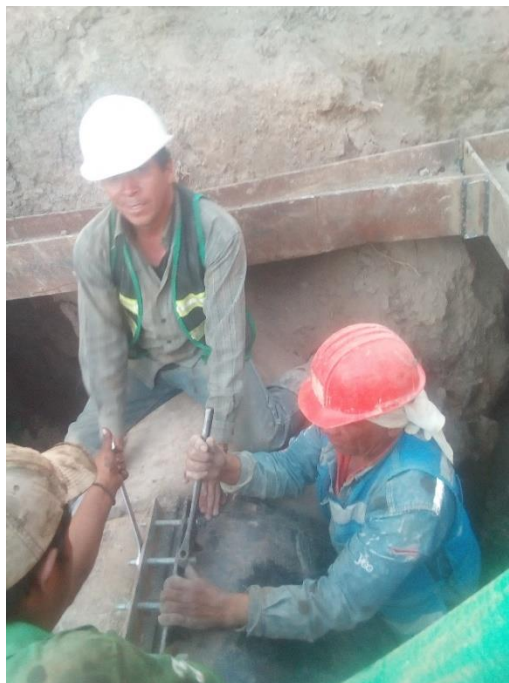
Imagen 62, colocación de pieza tipo silleta para derivación a 20"².
