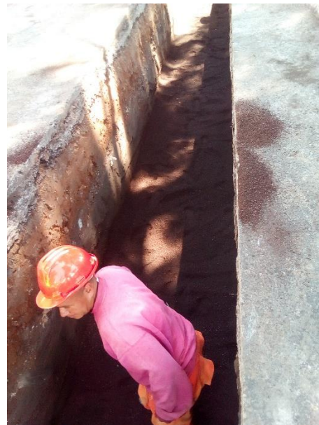
Imágenes 19 y 20, colocación de cama de arena con espesor de 20 cm.
