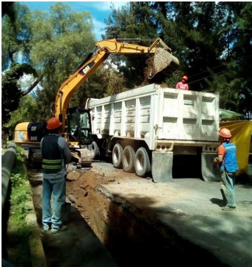
Imágenes 13 y 14, excavación en zanja 2 .
