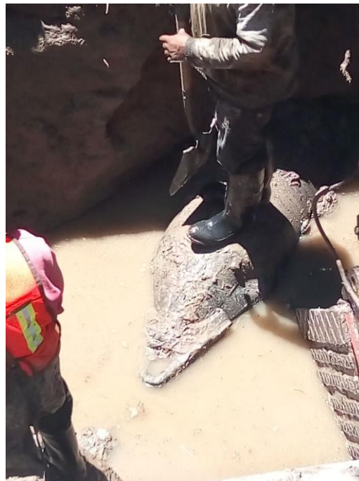
Imagen 60, salida de tubería de acero colocada por medio de perforación direccional en la ventana número 1 2 .
