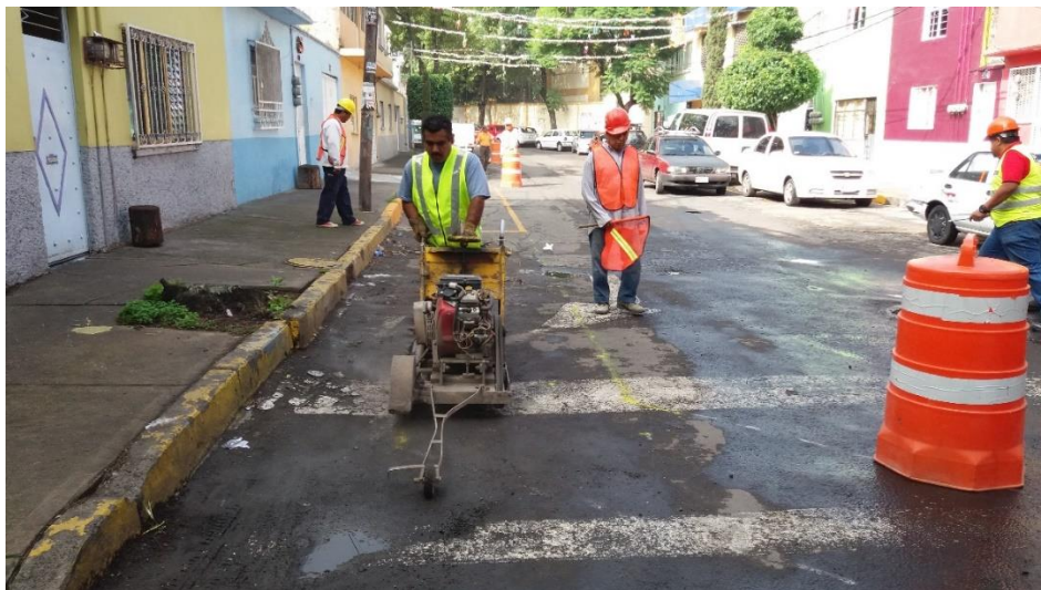
Imagen 8, corte con sierra de la carpeta asfáltica en calle norte 200.
