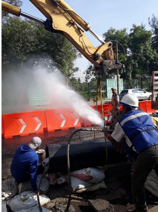
Imagen 26, desfogue del agua dentro de la tubería para liberar la presión y pasar el líquido a la siguiente tubería 2 .
