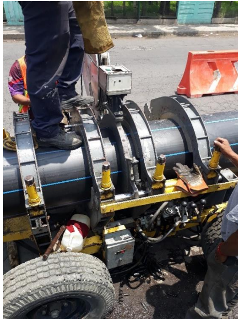
Imagen 22, carro de termofusión, plancha para calentar los extremos de la tubería.
