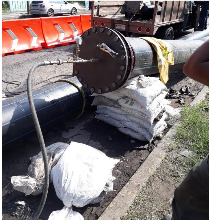
Imagen 24, llenado de tubería y aplicación de presión 2 .
