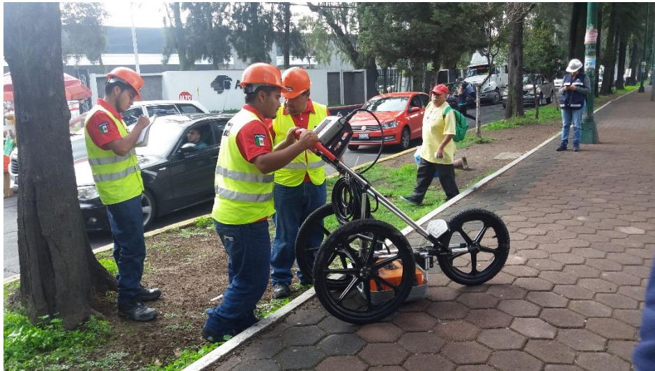
Imagen 11, uso de Georadar para identificación de interferencias 2 .
