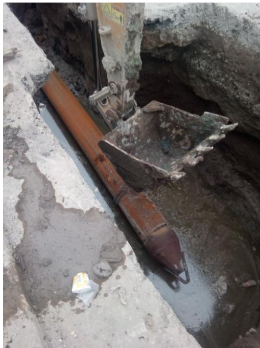
Imagen 58, posicionamiento de tubería de acero 2 .
