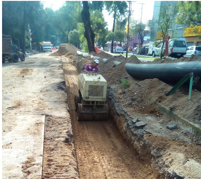
Imagen 31, compactación con equipo de rodillos vibratorios 2 .
