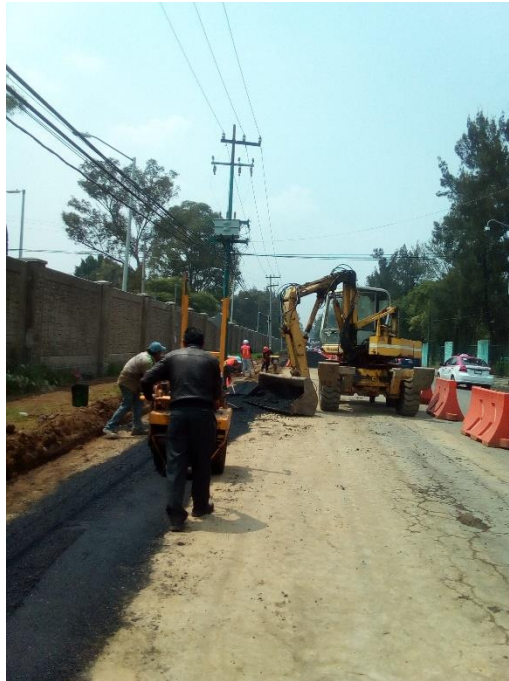
Imagen 35, tendido y compactación de la mezcla asfáltica con excavadora sobre ruedas Mecalac y rodillo vibratorio wacker 2 .
