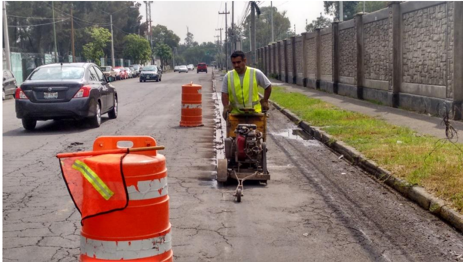
Imagen 7, corte con sierra de la carpeta asfáltica en calle Ruiz Cortines.
