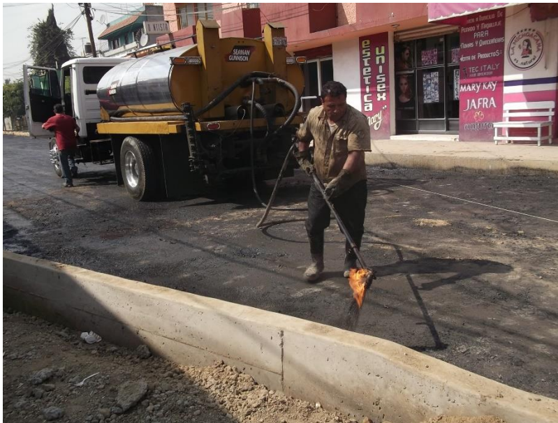
Imagen 34, colocación de riego de liga con petrolizadora 2 .
