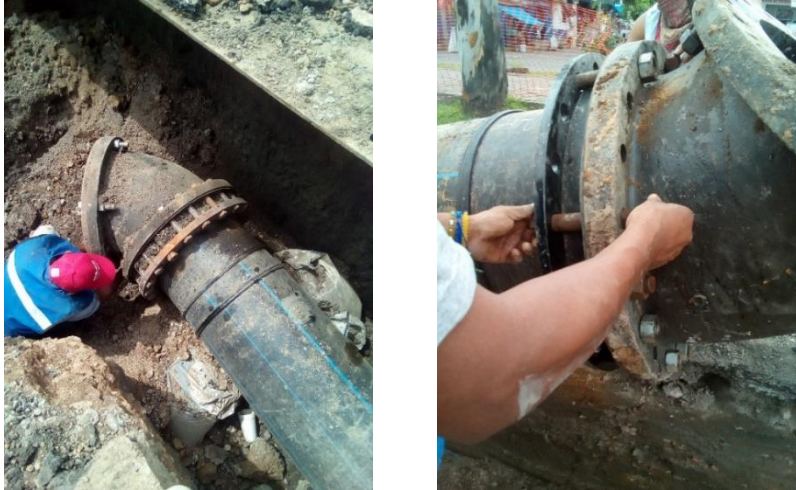
Imagen 27 y 28, instalación de codo de 45° 2 .
