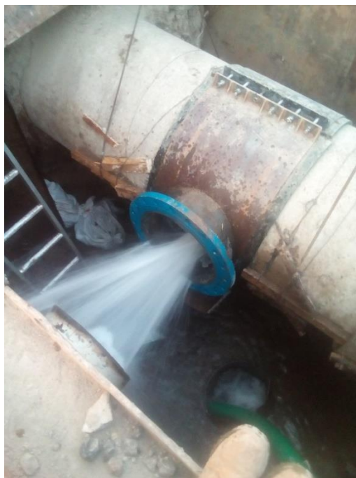
Imagen 65, demolición manual de la derivación 2 .
