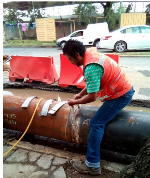
Imágenes 40 y 41, inspección de soldadura en juntas de la tubería de acero, por el método o de radiografía y líquidos penetrantes.
