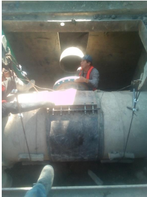
Imagen 64, demolición manual de la derivación 2 .
