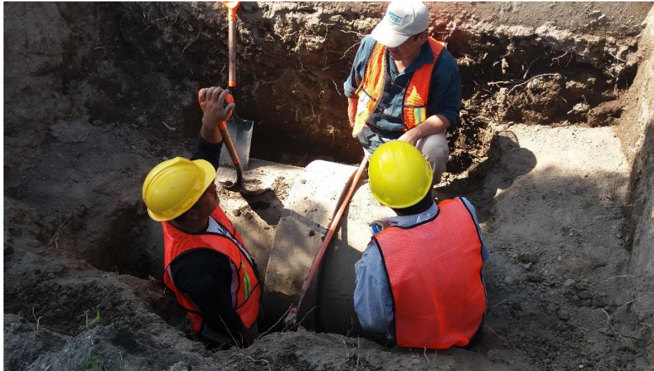
Imagen 45, excavación manual de ventana número 1, para no afectar a tubería de asbesto cemento de 36"².
