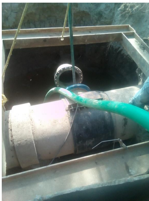
Imagen 63, colocación de pieza tipo silleta para derivación a 20"².
