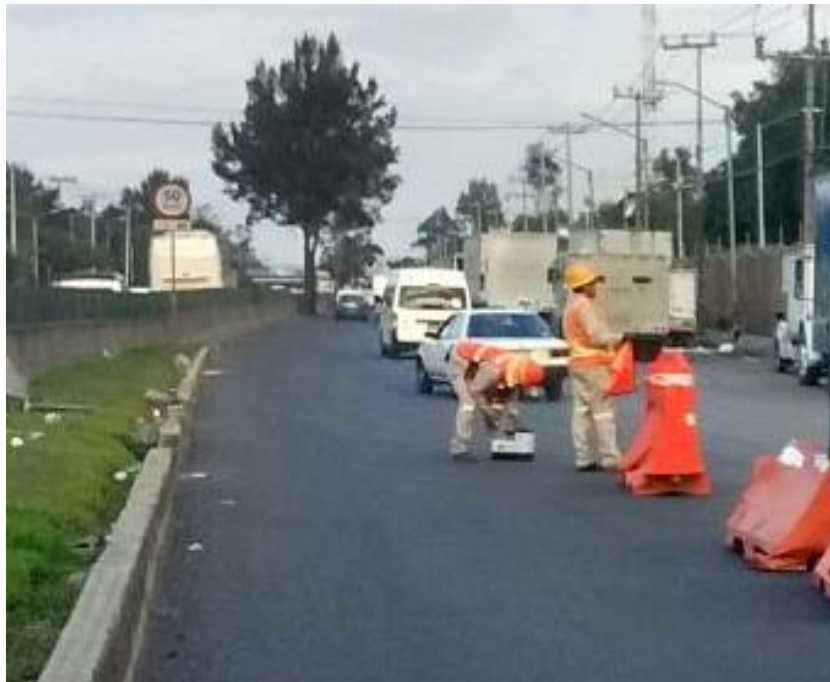
Imanen 49, seguimiento de la perforación piloto en la parte superficial a nivel de terreno natural 2 .
