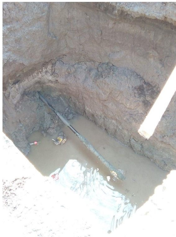
Imagen 51, salida de perforación piloto en la ventana número 2 2 .
