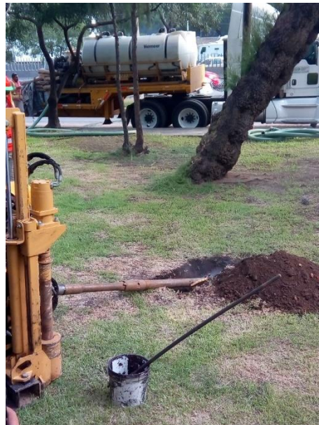
Imágenes 47 y 48, inicio de perforación direccional dirigida con perforación piloto 2 .
