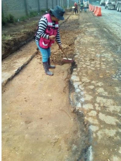
Imágenes 32 y 33, cajeo para colocación de carpeta asfáltica 2 .
