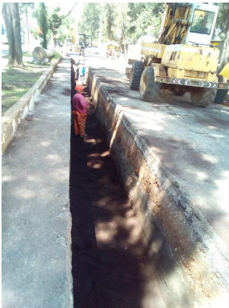
Imágenes 19 y 20, colocación de cama de arena con espesor de 20 cm.
