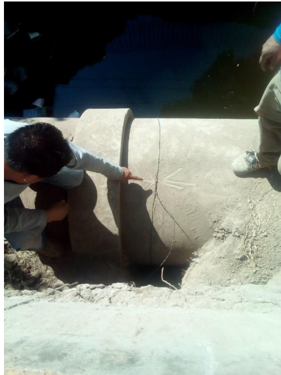
Imagen 61, medición de diámetro exterior de tubería de asbesto 2 .
