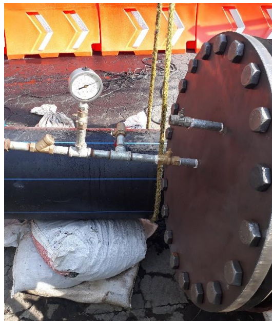
Imagen 25, verificación de presión constante 2 .
