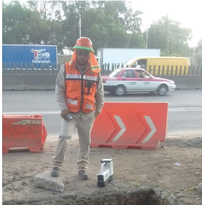
Imagen 50, personal de la perforación dirigida con equipo de detección de la punta de perforación piloto 2 .
