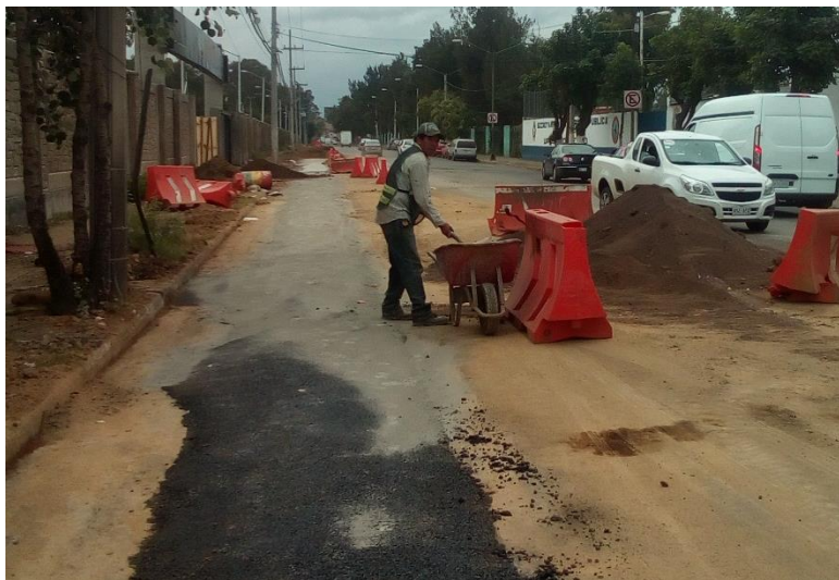
Imagen 36, colocación de sello de cemento en la carpeta asfáltica 2 .
