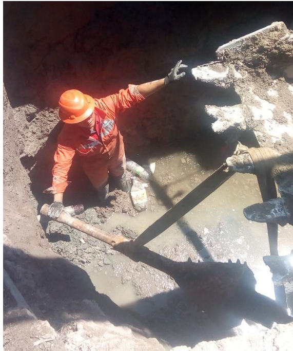
Imagen 53, colocación de punta para retroensanchado 2 .
