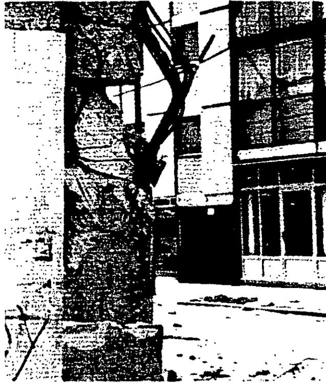
*Figura 3.10. Falla del paquete de varillas en columnas.*
