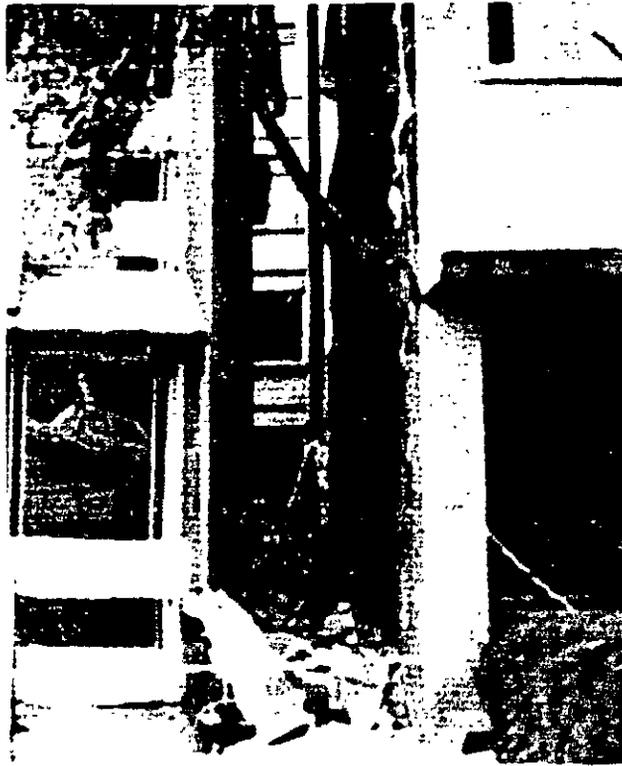
*Figura 3.18. Falla en edificio por el llamado "piso suave".*
