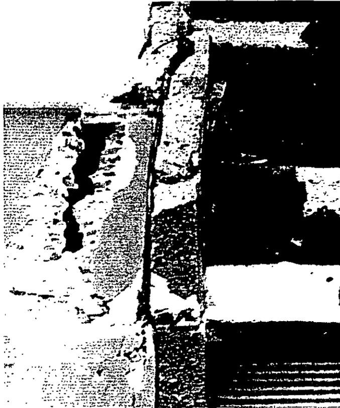
*Figura 3.12. Daño en columnas por golpeteo con estructuras vecinas.*
