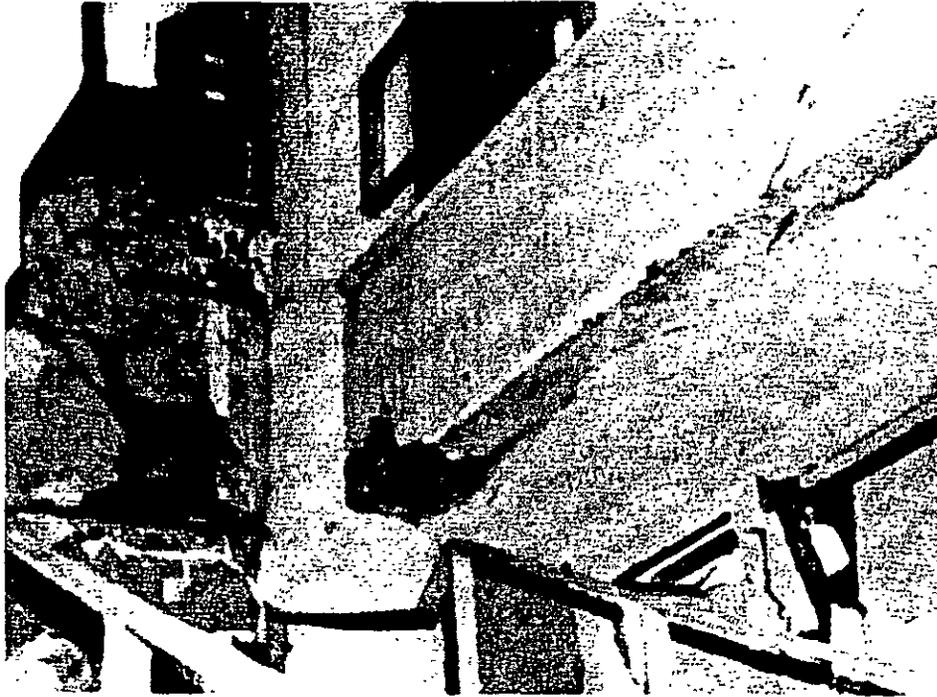
*Figura 3.3 Falla por compresión en trabes.*
