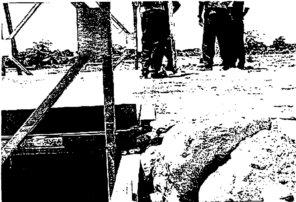
Figura 17. Se aprecia el perfil tubular cuadrado que sirve como cerramiento.
