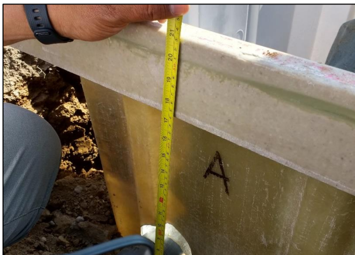
Figura 6.4 Profundidad establecida en zanjas
