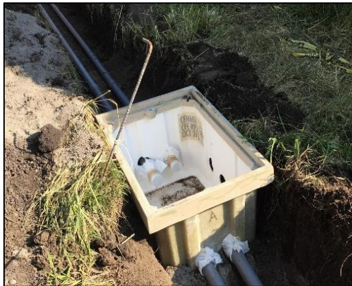
Figura 6.6 Instalación de un registro y tubería
