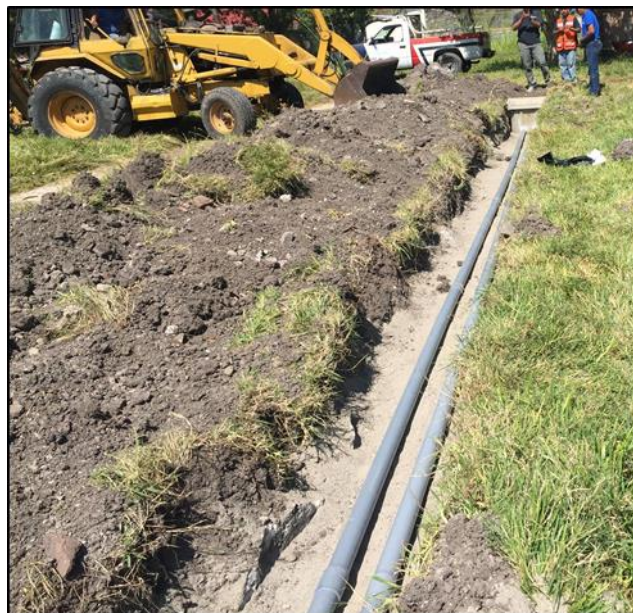
Figura 6.3 Instalación de tubería principal en una zanja
