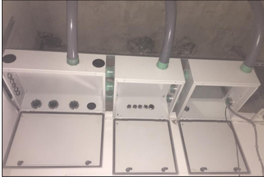
Figura 8.4 Registros metálicos instalados
