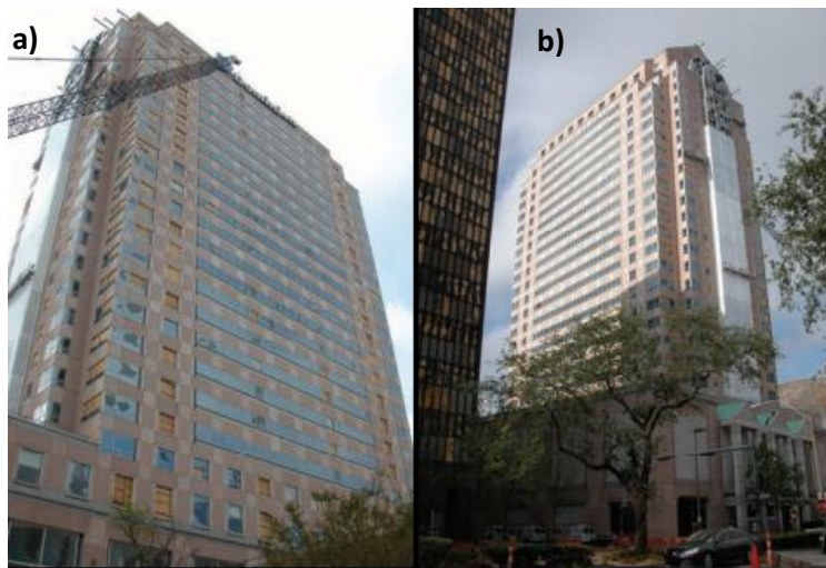
Figura 1.4 Daños en fachada de la Torre Dominion (Mosqueda, G. y Porter, K., 2007)
