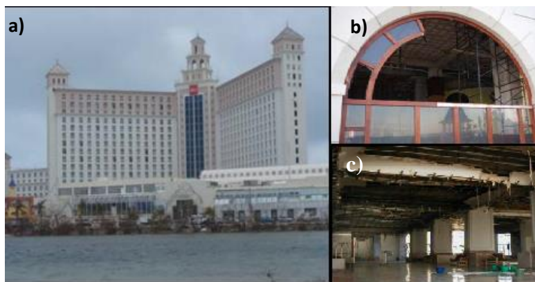
Figura 1.5 Fachada principal y daños en Hotel Riu Cancún (Ramírez, J., 2007 y Alva, O., 2015)
