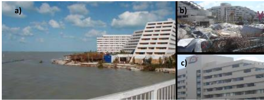
Figura 1.6 Daños en Hotel Park Royal Pirámides (Ramírez, J., 2007 y Alva, O., 2015)
