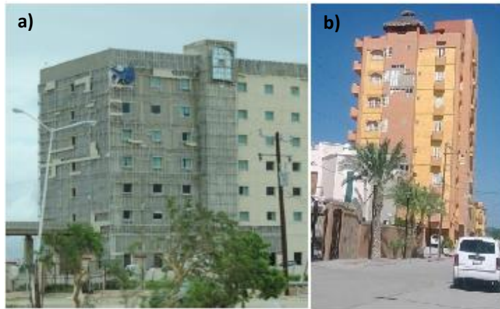
Figura 1.2 Daño en fachada de hotel (a) y edificio de condominios (b) (Muria, et. al., 2015)
