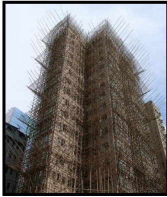
Fig. 7. "Andamiaje de bambú". Fuente: Valhondo, 2003.
