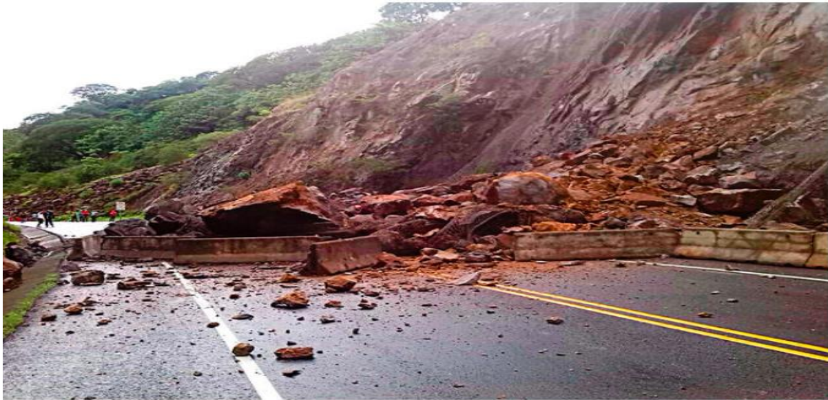
Figura 1.5 Fallo del talud, en la Ciudad de Caldera, Chile. Junio 2015
