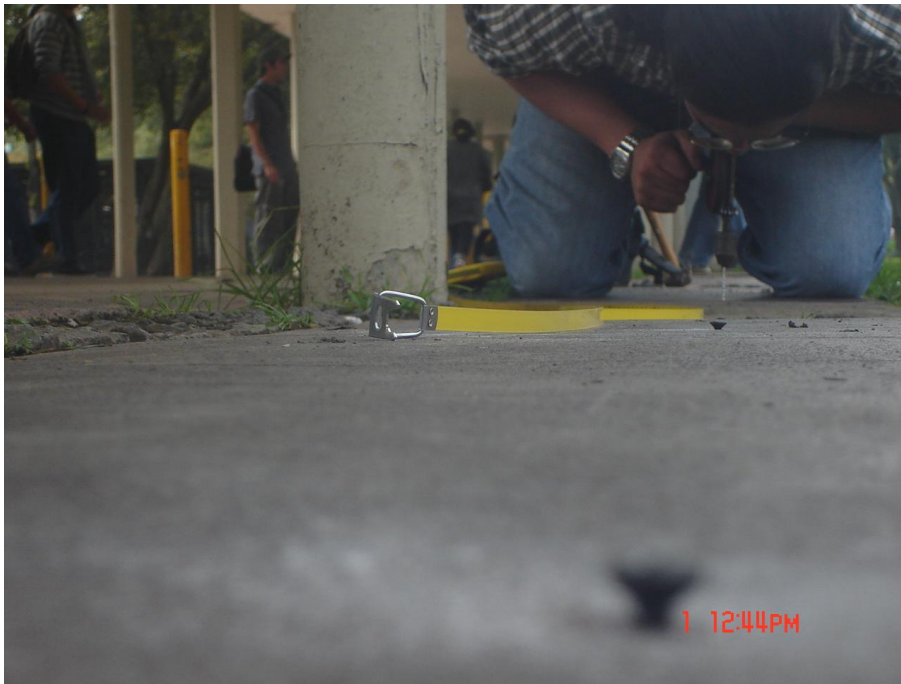
Perforación con taladro manual, para inserción de tornillos.
