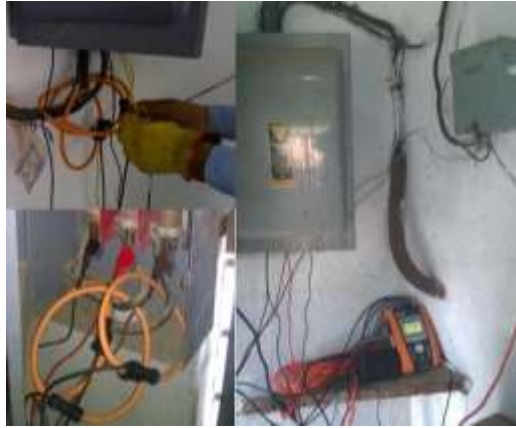
Figura 2-6.- Instalación de Analizador de redes
