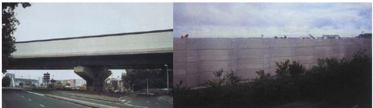
Figura 3.16. Barreras de lámina de aluminio (izq.) y de concreto (der) (English, 2001)
