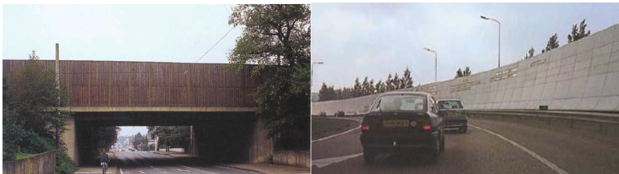
Figura 3.17. Barreras de madera (izq) y de lámina de acero (der). (English,2001)
