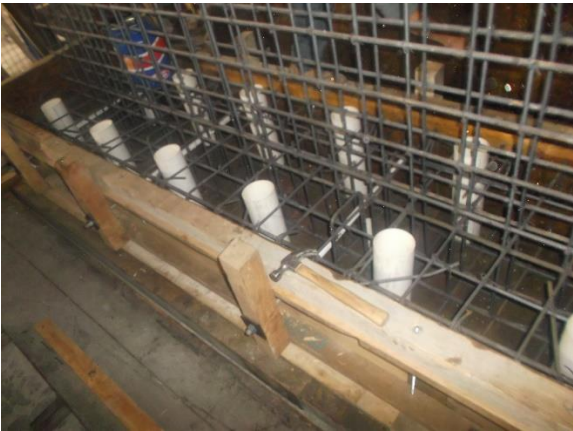
c) Armado de zapara de muro
