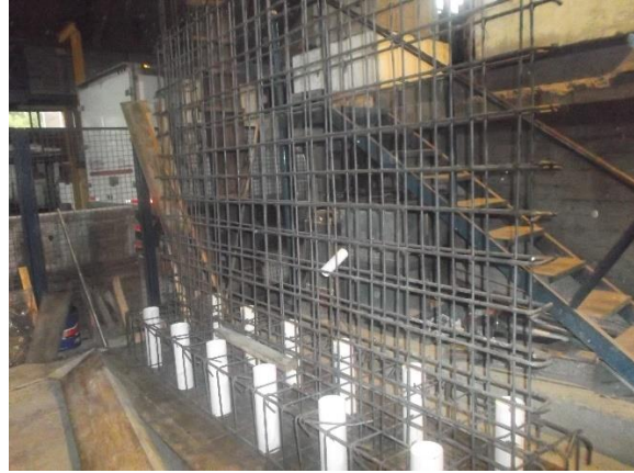
b) Armado de muro
