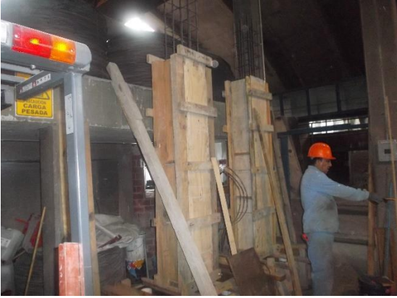
a) Cimbrado de columnas
