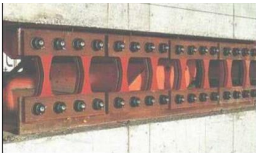
Figura 2.6 Disipador tipo Honeycomb (Gatica, 2012)
