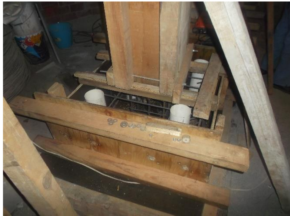
c) Armado y cimbrado de zapata de columna
