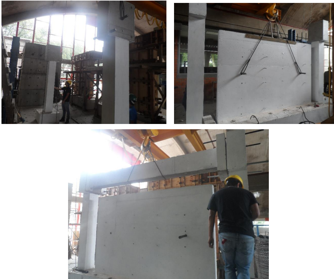
Figura 3.6 Montaje del arreglo marco-muro
