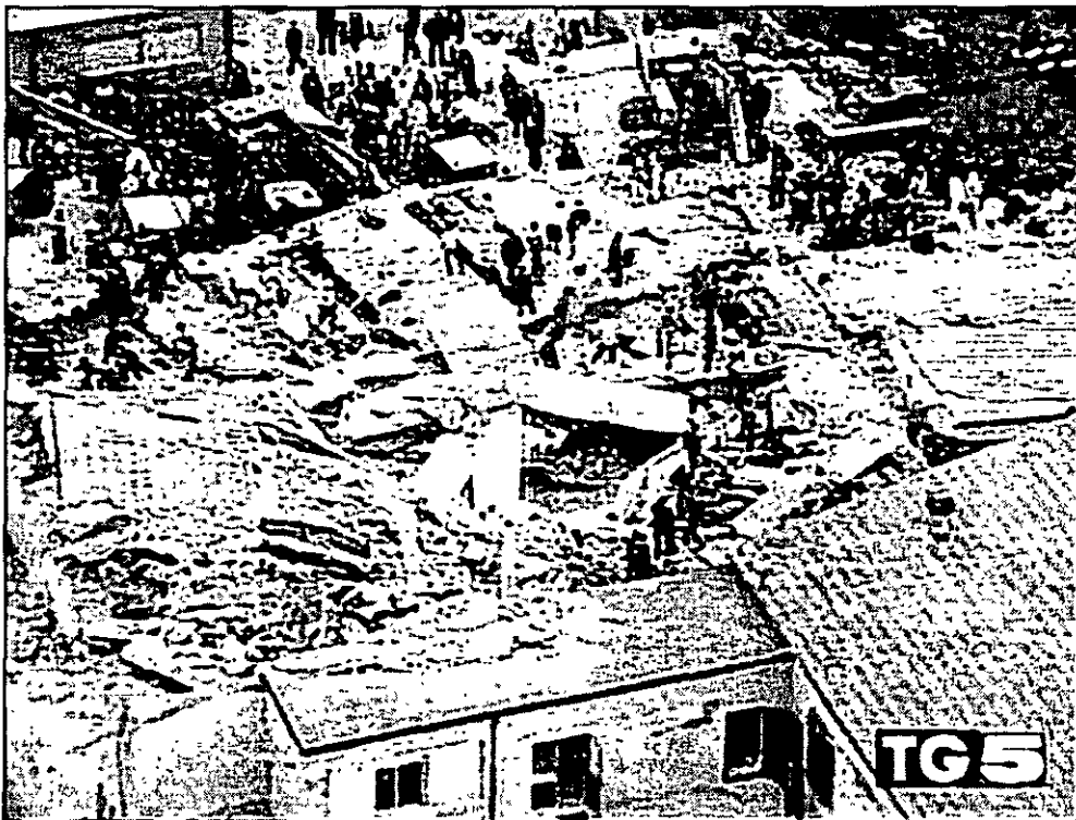
Figura 2.2 Colapso de un edificio por implosión (Italia, octubre del 2002)
