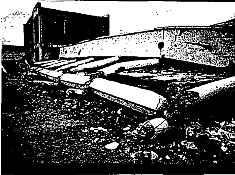
Sismo del 10 de Octubre de 1980, El Asnam, Algeria. Edificio moderno de escuela, el sismo ocurrió después de clases por lo que no hubo víctimas, Fotografía: Stanford University (H C Shah).
