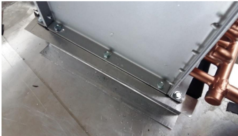
Fig. 158 Ensamble con tornillos autoperforantes del ducto de limpieza con el intercambiador de calor
