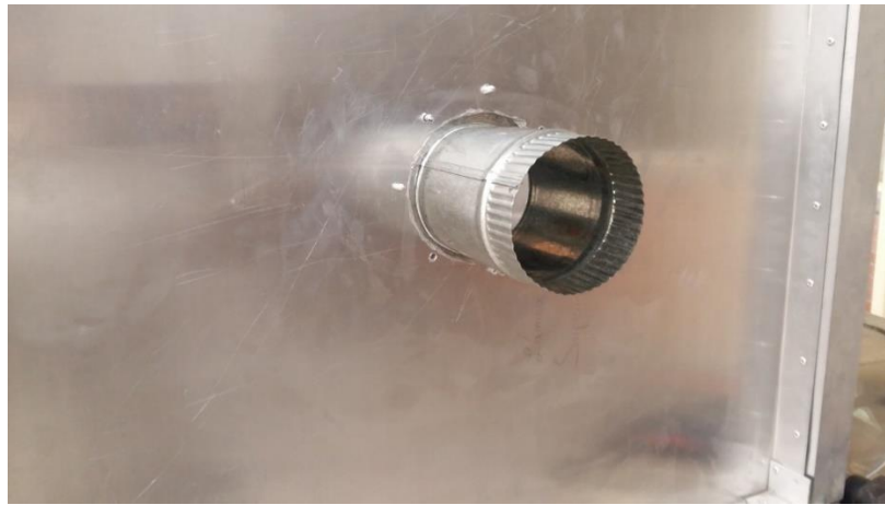
Fig. 91 Instalación de chimenea
