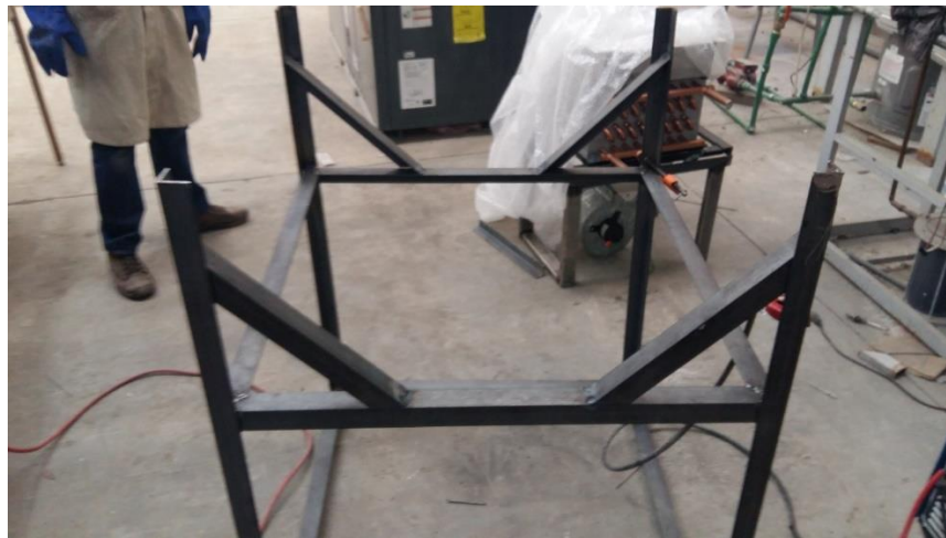
Fig. 123 Refuerzos a 45[°] soldados al marco inferior
