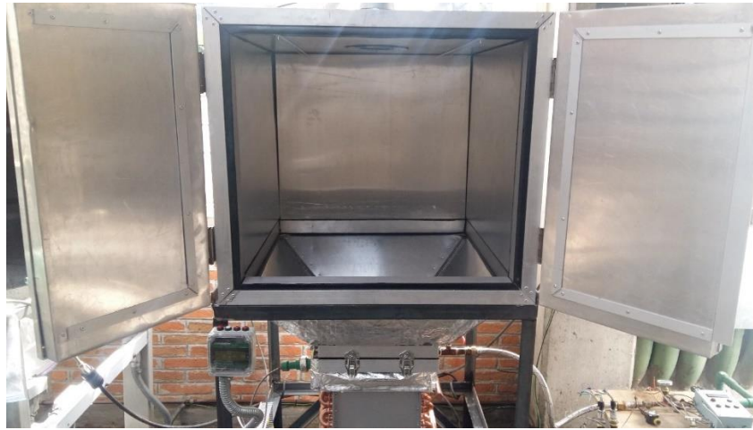
Fig. 189 Limpieza de cámara de deshidratado con mayor espacio libre para movilidad
