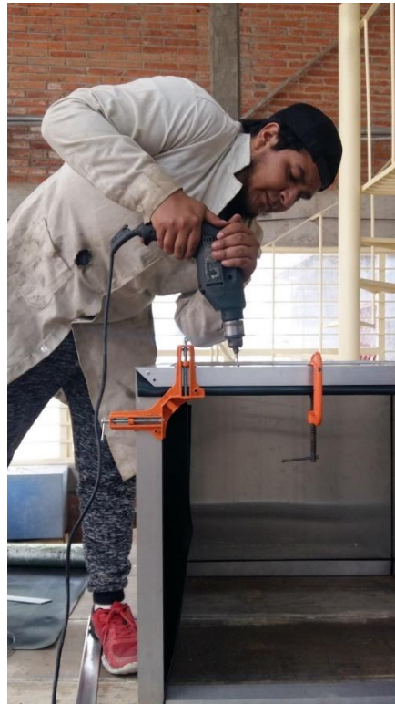
Fig. 88 Colocación del marco de ángulo de aluminio y neopreno
