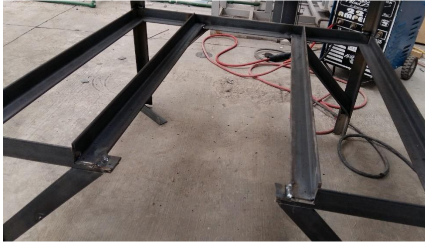
Fig. 126 Corte con esmeril del tramo sobrante de perfil angulado
