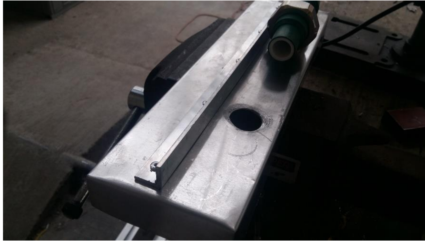
Fig. 155 Instalación de perfil angulado de aluminio y barrenado de orificio para colocar tubería de desagüe
