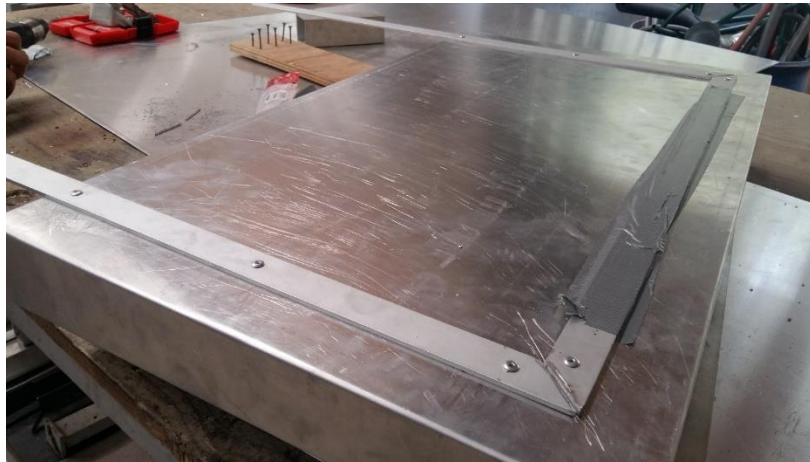
Fig. 97 Colocación de sellos internos de solera
