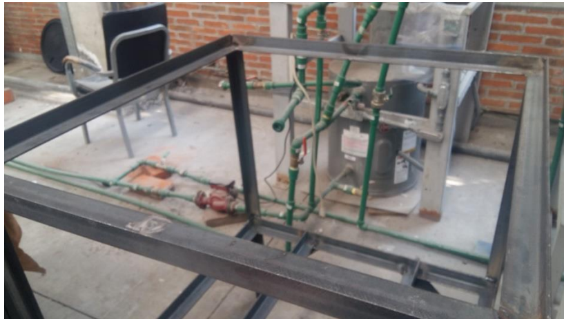
Fig. 119 Marco superior de la estructura soldado
