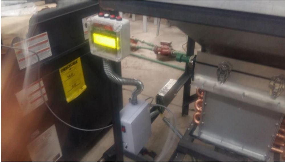
Fig. 176 Instrumentación instalada a la estructura del deshidratador
