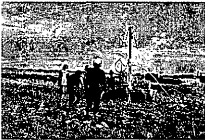
Aspecto de la perforación de pozos de inyección
