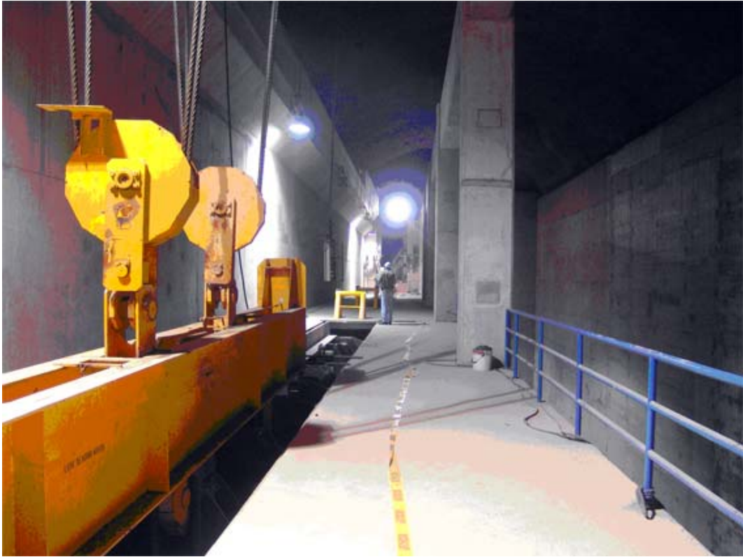
Fig. 2.23 Vista exterior de túnel de desfogue
