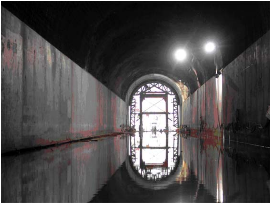
Fig. 2.21 Compuertas de mantenimiento del túnel de desfogue
