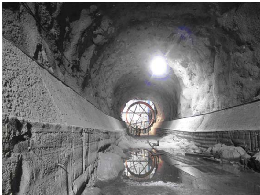
Fig. 2.12 Túnel en el que se montó la tubería de presión. Al fondo se observa la casa de máquinas
