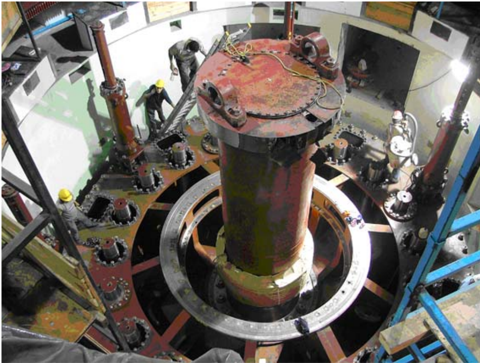
Fig. 2.17 Armado del laminado del rotor
