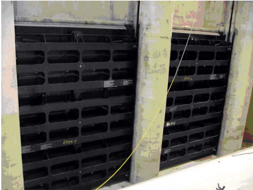
Fig. 2.21 Compuertas de mantenimiento del túnel de desfogue
