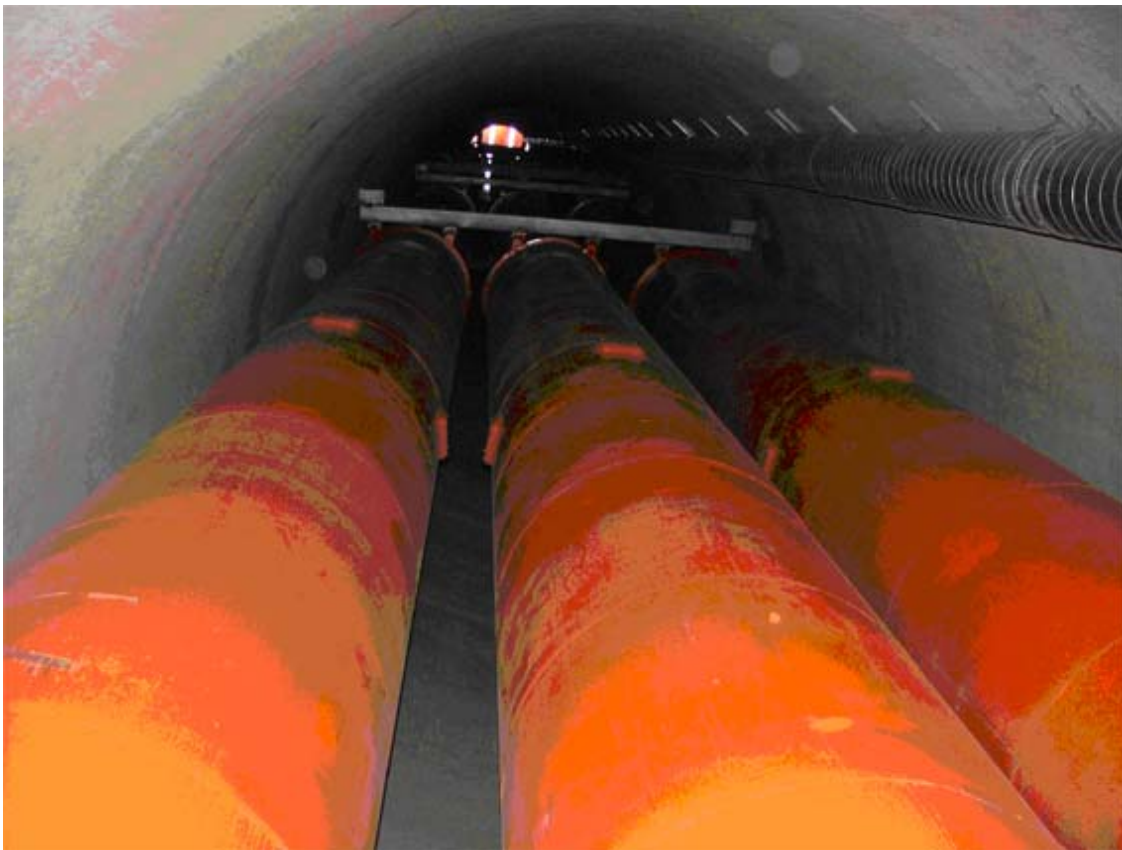
Fig. 2.18 Bus de fase aislada
