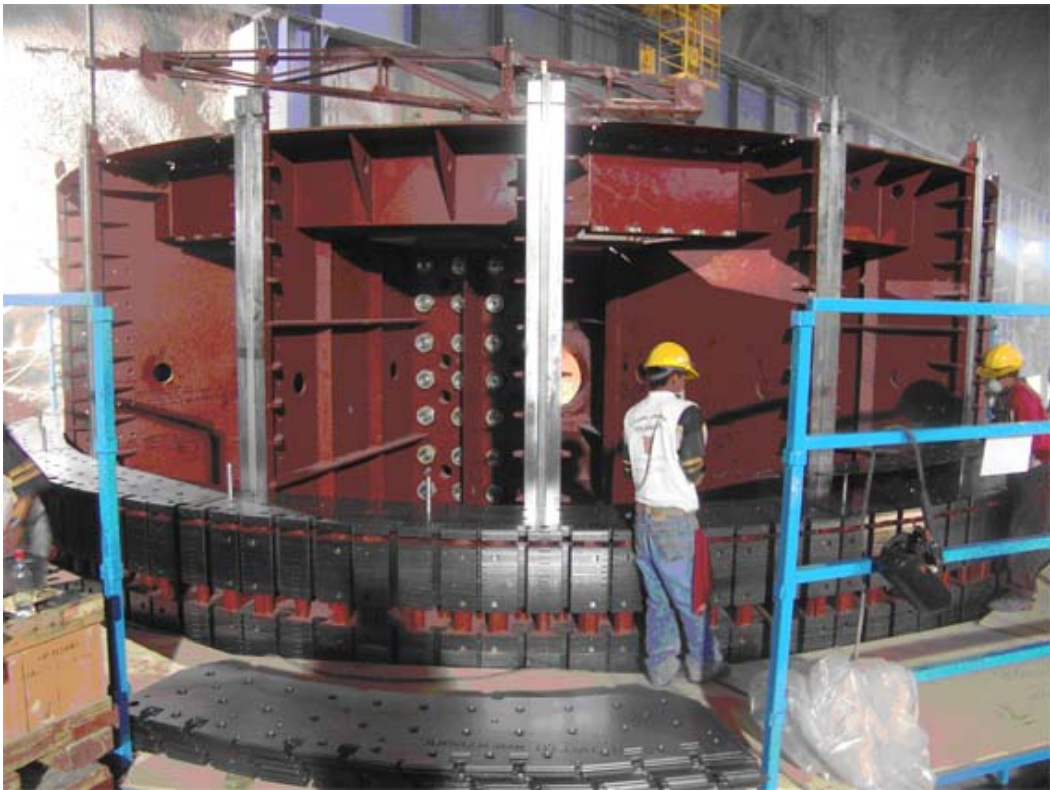
Fig. 2.17 Armado del laminado del rotor
