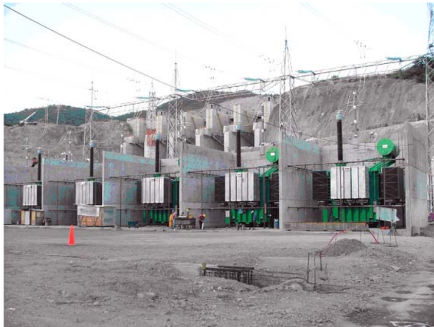
Fig. 2.28 Transformadores elevadores. El bus de fase aislada se conecta por la parte posterior
