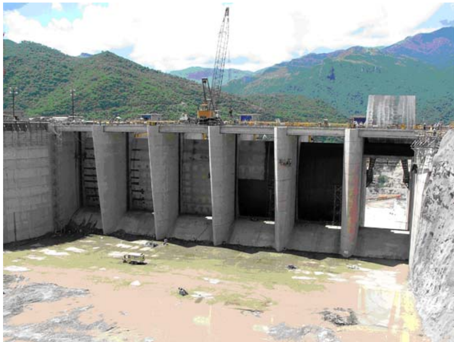
Fig. 2.33 Prueba de levantamiento de la compuerta cilíndrica, sin agua
