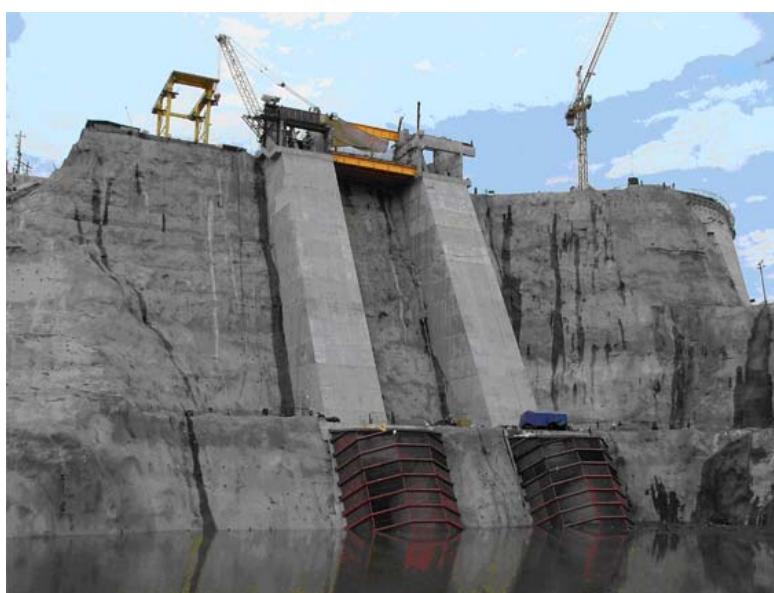
Fig. 2.9 Obra de toma concluida, empezando a llenar el embalse
