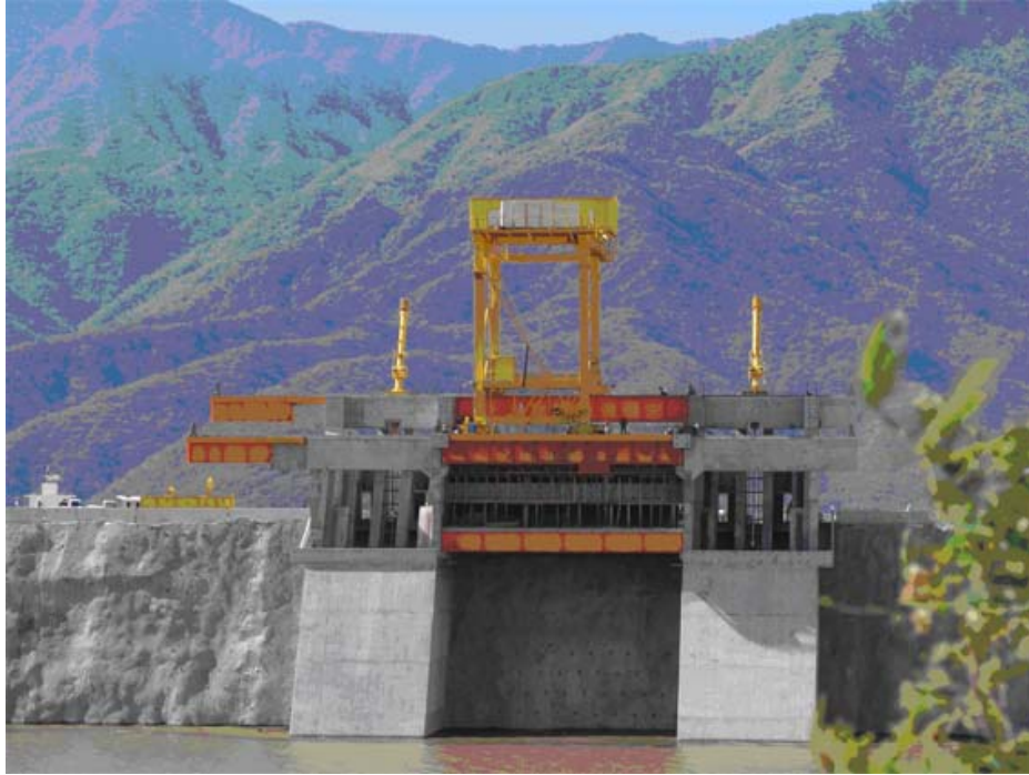
Fig. 2.10 Vista final de obra de toma, con el embalse lleno. En la parte superior se aprecia la grúa pórtico
