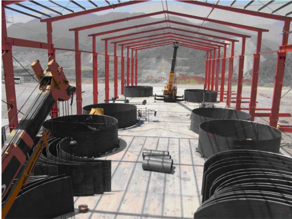
Fig. 2.12 Túnel en el que se montó la tubería de presión. Al fondo se observa la casa de máquinas
