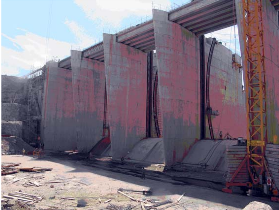
Fig. 2.33 Prueba de levantamiento de la compuerta cilíndrica, sin agua
