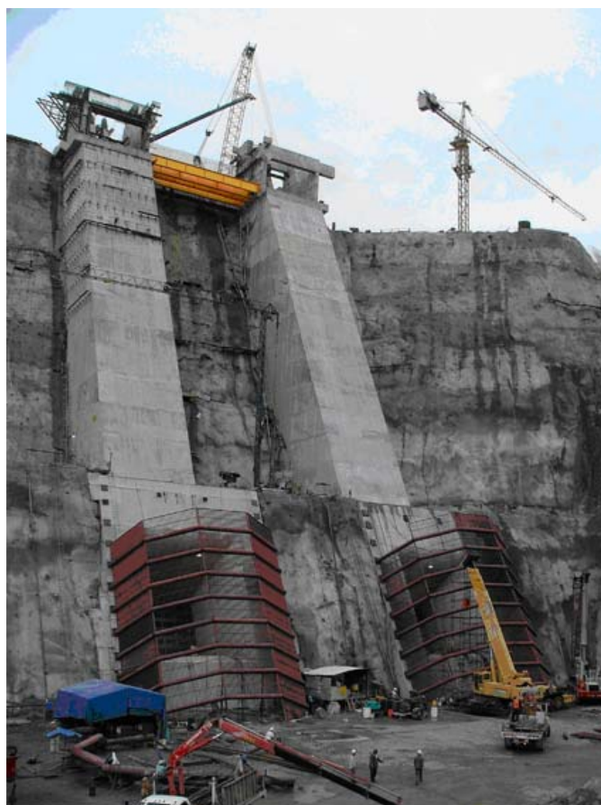
Fig. 2.9 Obra de toma concluida, empezando a llenar el embalse
