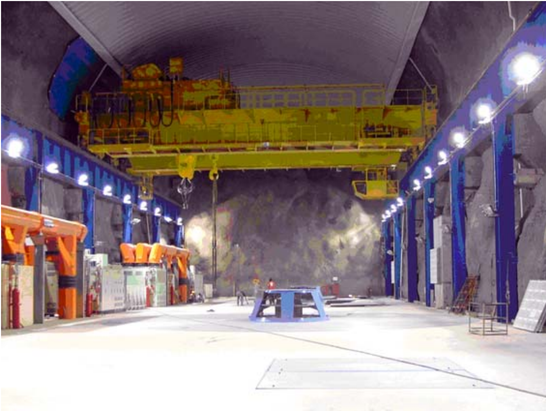
Fig. 2.19 Vista final de la casa de máquinas. En la parte superior se aprecia una de las dos grúas viajeras
