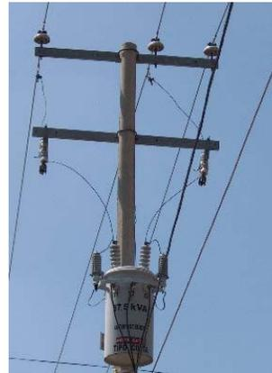
Para subestaciones de potencia usualmente se realizan estudios de coordinación de aislamiento para seleccionar los apartarrayos adecuados para dicha subestación. En estos estudios de coordinación de aislamiento se toman en cuenta factores como estudios atmosféricos, altitud, carga conectada, etc.
