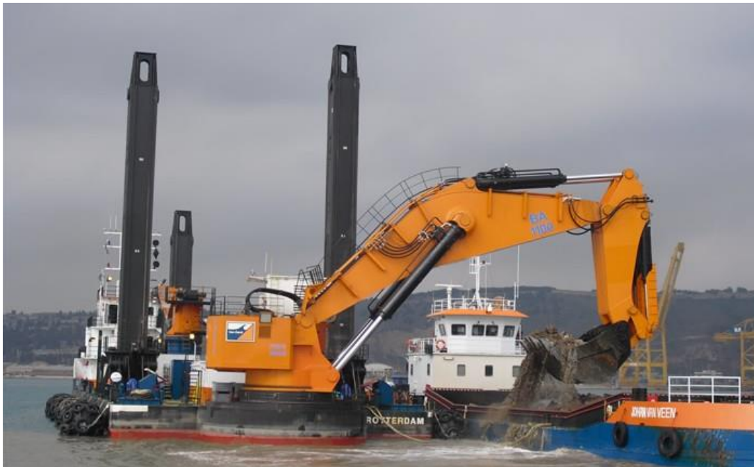
Figura 4. 9. Draga tipo retroexcavadora. Fuente: DRAVOSA. Dragas de retroexcavación.
