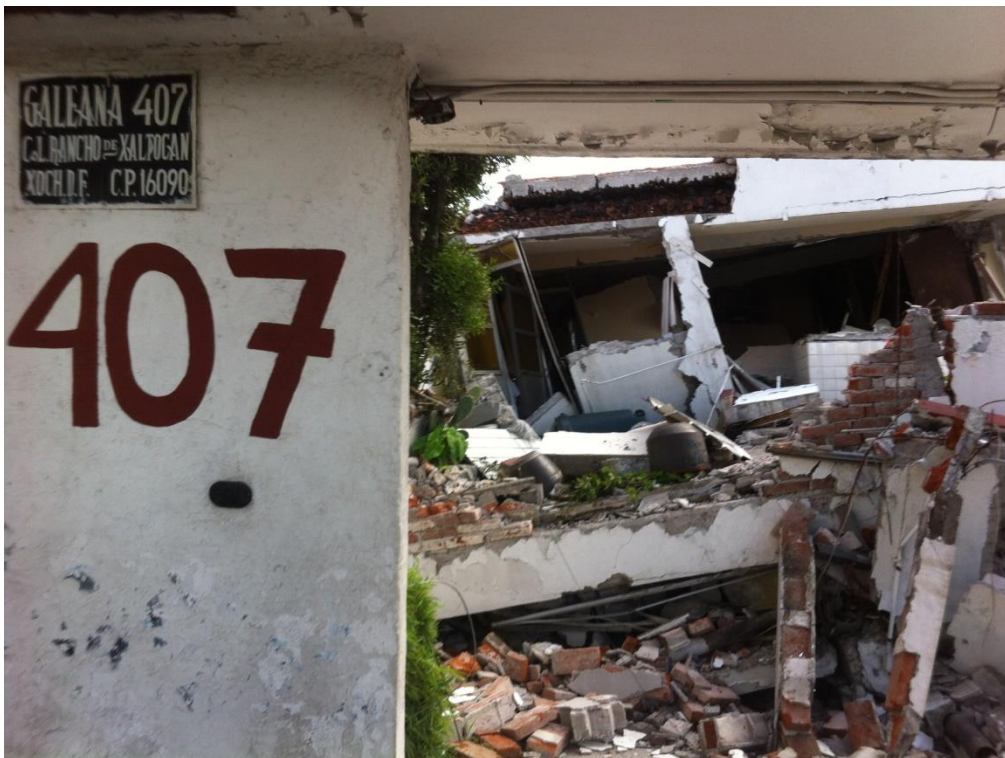
Imagen 2.1. Vivienda derrumbada en el barrio Xaltocan, Delegación Xochimilco.
