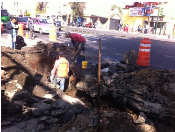
Imagen 2.6. Reparaciones a la red de abastecimiento de agua potable.
