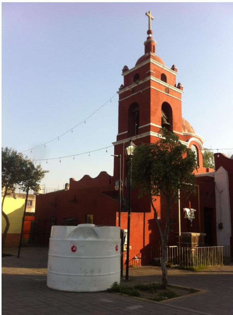
Imagen 2.10. Instalación de tinacos de 10 mil litros en los espacios públicos.
