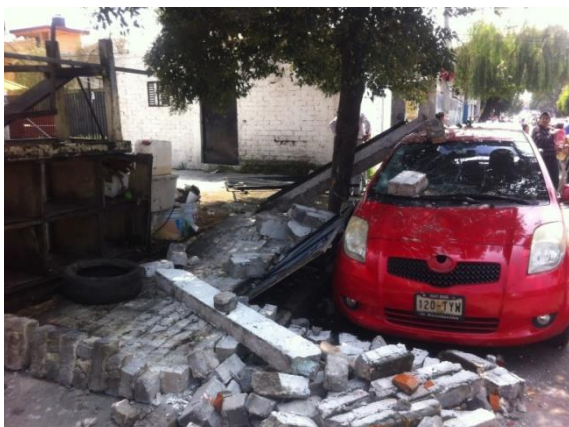
Imagen 2.2. Derrumbes cobraron vidas y pérdidas materiales.
