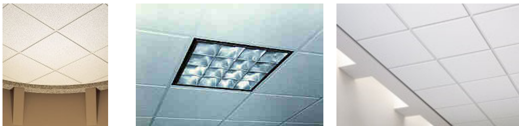
Figura 4.4 Ejemplos de plafón instalado
