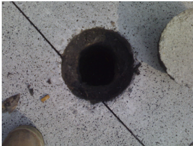
Fig. 23: Perforación para puesta a tierra
