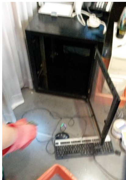
Fotografía 8. Retiro de servidor anterior y limpieza de armario.
