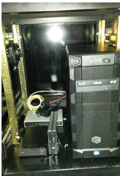
Fotografía 9. Instalación del nuevo servidor con cableado y discos duros externos.
