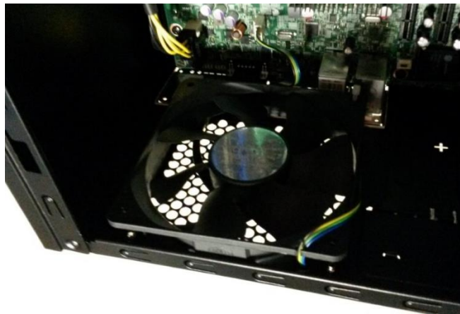
Fotografía 2. Segundo ventilador, extrae aire solamente.
