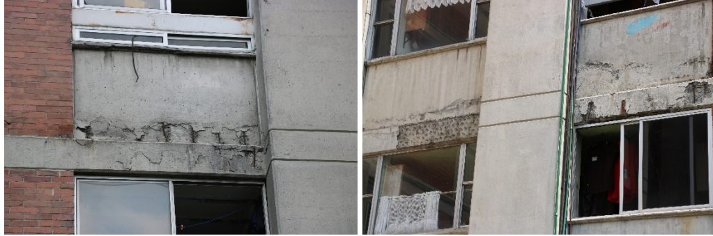
Figura 2.12 Armado de nervaduras expuesto en los edificios Argentina y Brasil (archivo personal, 2018)
