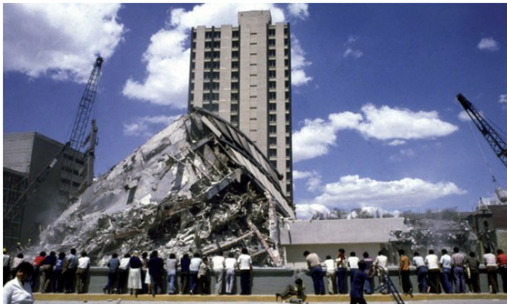
Figura 1.19 Colapso del Conjunto Pino Suarez en la delegación Cuauhtémoc (fotografía por Jesús V., 1985)
