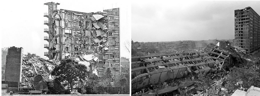
Figura 2.4 Colapsos en el CUPJ y del edificio Nuevo León en Tlatelolco (fotografías por Excelsior y Marco A. Cruz, 1985)
