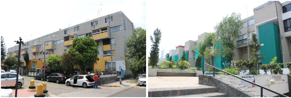
Figura 2.7 Fachada oriente del edificio Perú a la izquierda y plaza elevada de acceso a los departamentos de las plantas superiores del edificio Granda a la derecha (archivo personal, 2018)
