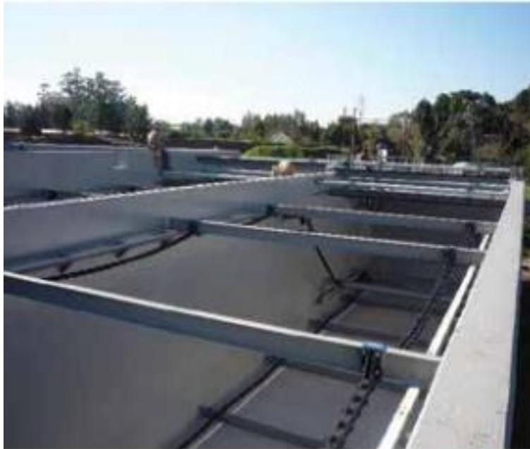
Figura 12. . Sedimentador primario rectangular (Fuente: Operación y Mantenimiento de Plantas de Tratamiento de Aguas, CONAGUA).
