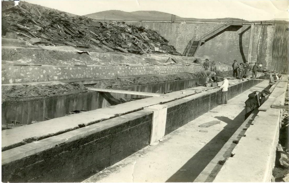
Figura 15. Cementación de cobre en canaletas (Ballester M. 2018)
