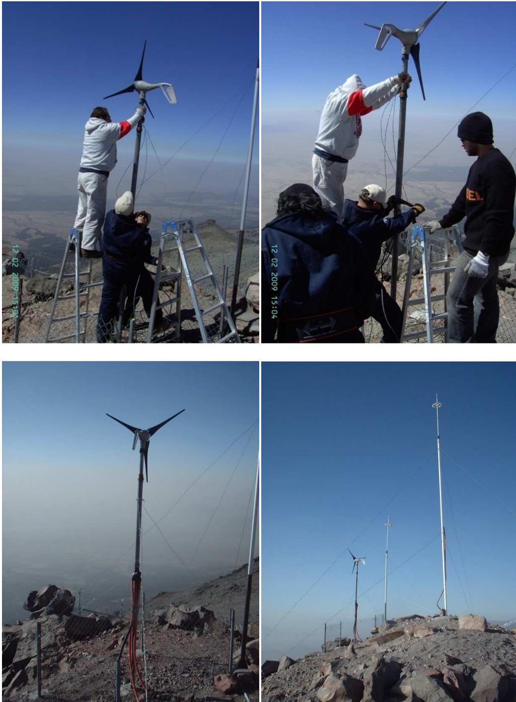
Figura 5.10 Montando y cableado del aerogenerador en su sitio de operación en Sierra Negra Puebla.
