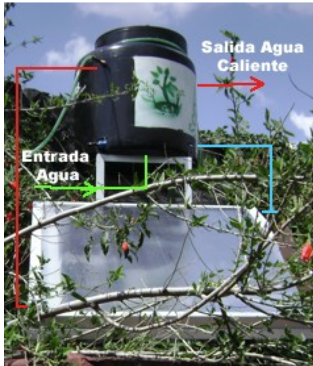
Figura 13. Diagrama de instalación
