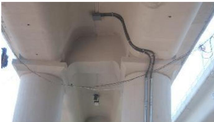
Se aprecia como la caja cuadrada montada en la trabe se conecta con el tubo conduit flexible (sujetado este con abrazaderas), para continuar con la canalización de los cables que alimentaran toda la luminaria del distribuidor vial, para finalmente llegar hasta los interruptores termo magnéticos de gabinete.
