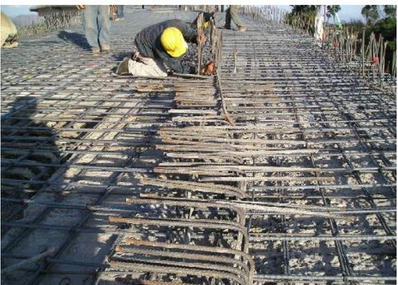
Se efectúa el anclaje entre el acero de la trabe y el acero del firme de compresión.
