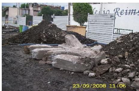
Fragmentos de concreto procedentes de la demolición de pilotes.
