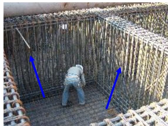
Colocación de estribos con varilla del #4
