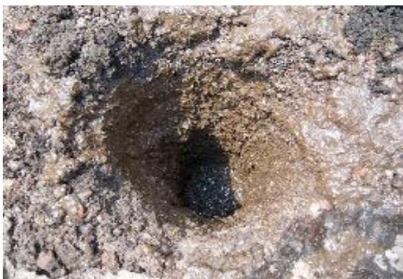
Perforación previa para el hincado de vigas
