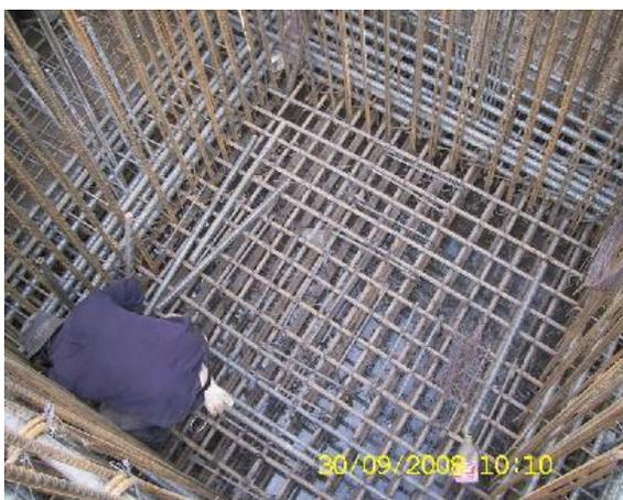
Armado de la Losa Fondo del Candlero con varilla del #6, con dos parrillas
