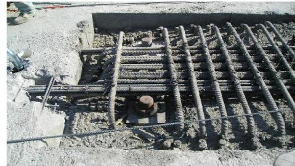
Descimbrado y preparaciones para iniciar el pos tensado de los torones.
