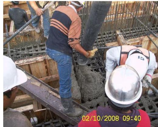
Colado de la zapata con una resistencia a la compresión de  $300 \text{ kg/cm}^2$ ,
