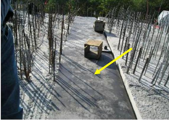
Colocación de una junta de calzada
