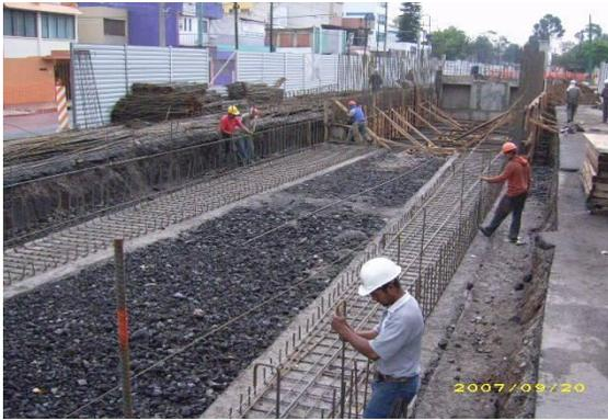
Armado de los muros de contención
