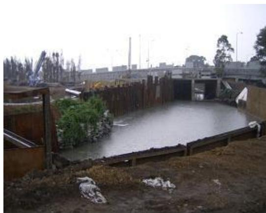
Canalización de aguas negras del río San Buena Aventura sin interferir con los trabajos de excavación
