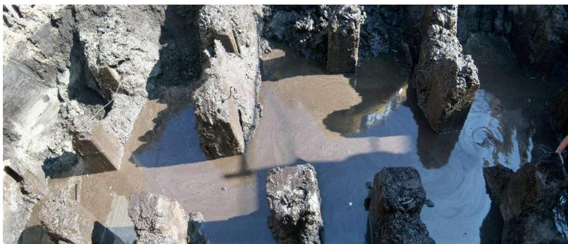
Inundación de zapatas debido a lluvias o a tuberías de drenaje que se fracturaban en el momento de los trabajos
