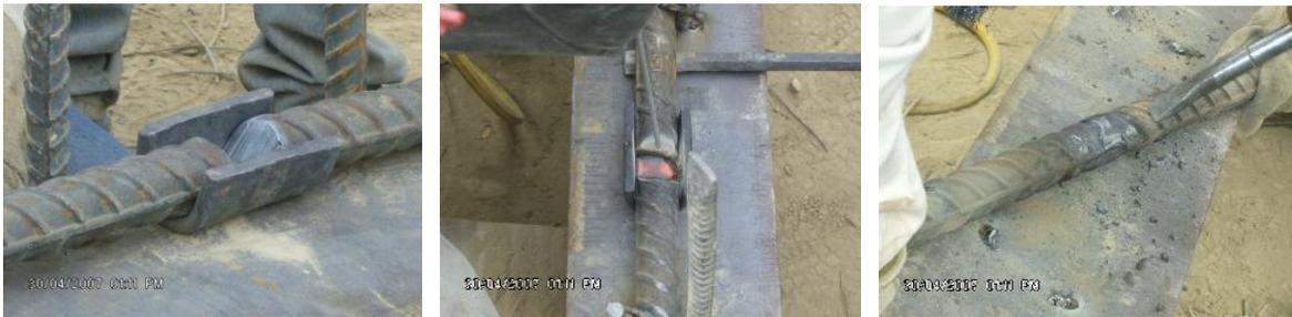
Empalme mediante Bulbeo (Varillas soldadas con diámetros iguales ó mayores del #8)
