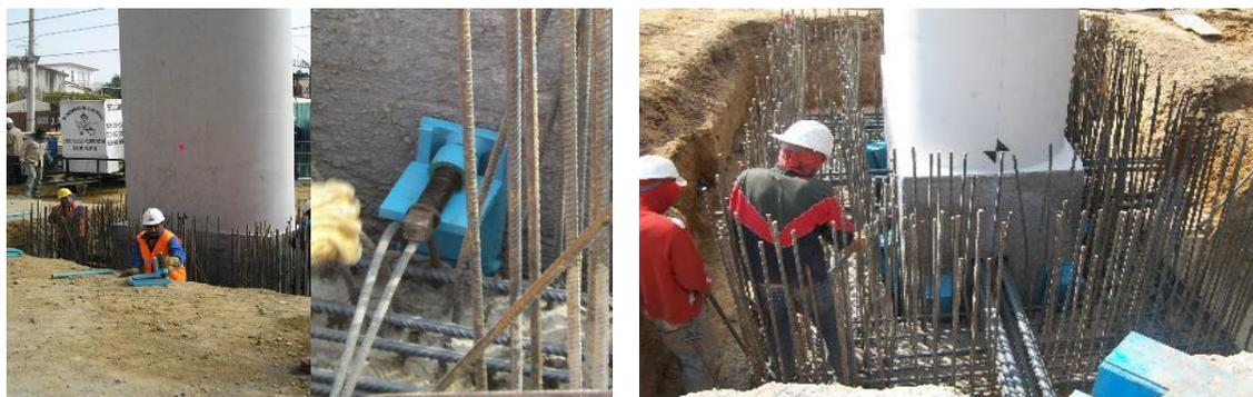
Descenso de la columna hasta el fondo del candlero y colocación de las cuñas estabilizadoras metálicas
