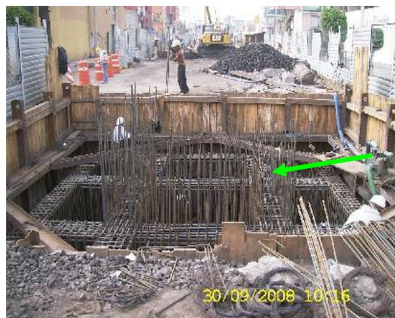
Armado de las paredes del Candlero revestido con estribos del #5
