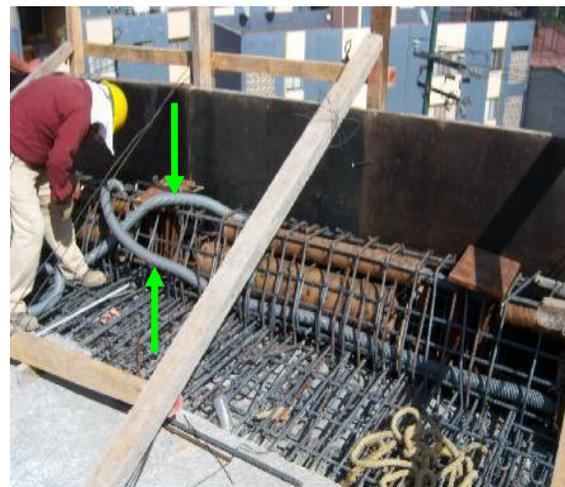
Tubería eléctrica para alumbrado sobre puente
