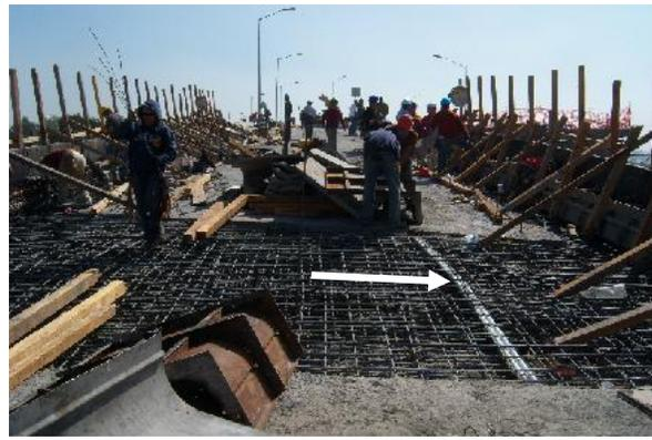
Tubería de PVC flexible de 51mm para alumbrado bajo puente
