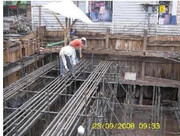
Armado del acero principal longitudinal y transversal con varilla del #12
