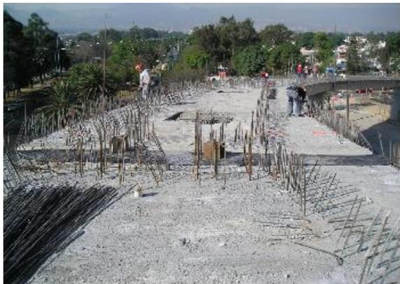
Acero de refuerzo de la trabe que servirá para el anclaje de esta con el firme
