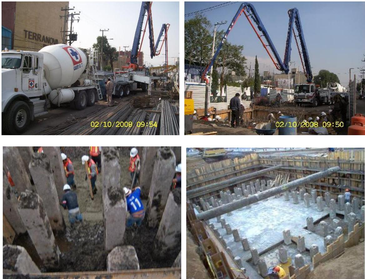
Colado de la plantilla de concreto simple en toda el área de la zapata.
