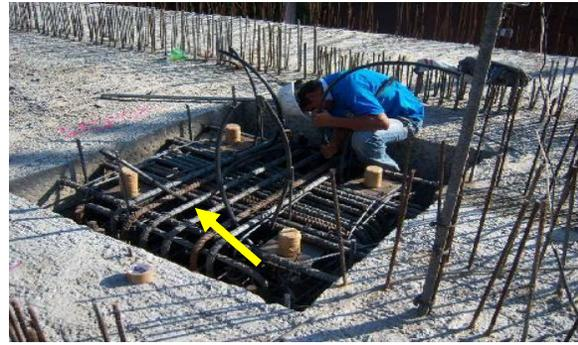
Armado de la conexión trabe-columna, colocando varillas del #10 en forma de U para realizar la grapa
