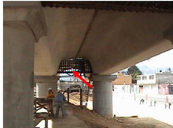
Armado del cabezal que conecta estructuralmente a dos traveses tipo TA6
