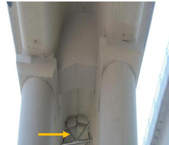
Diafragmas metálicos con tubería de diámetro de 4"
