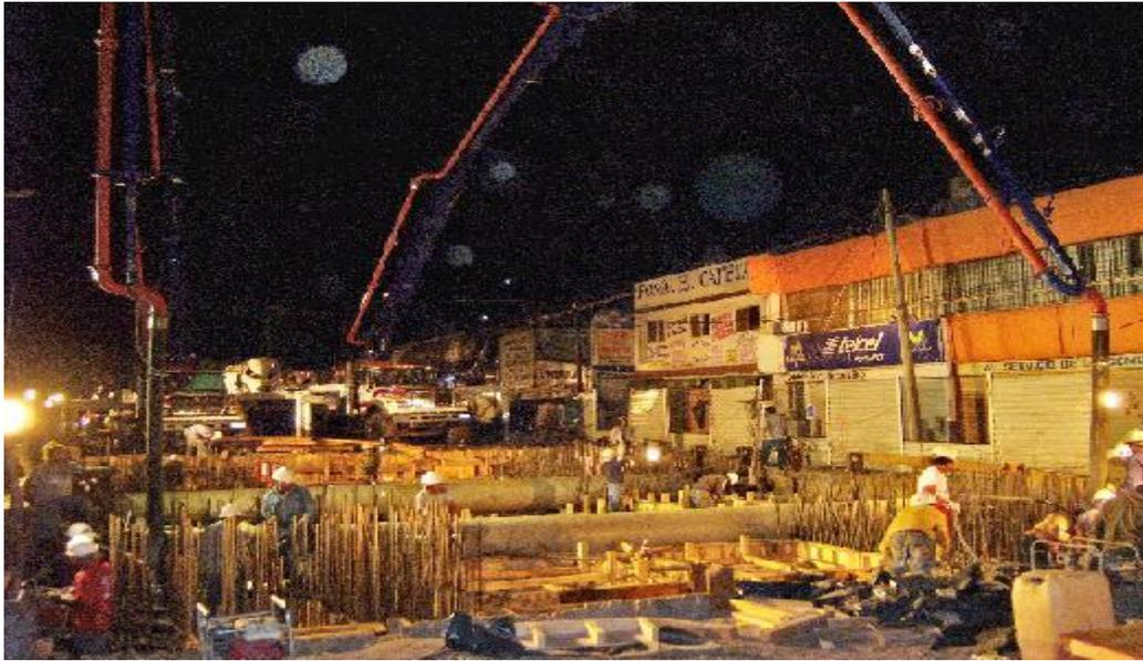
Al concreto se le procedió a aplicar un aditivo fluidificante, para hacerlo manejable y bombeable (que para este caso llego a ser hasta de 30m).
