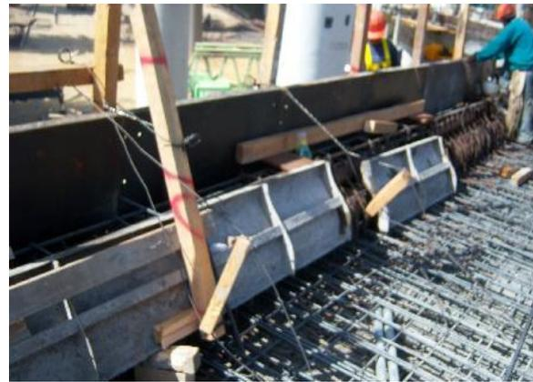
Cimbra metálica del parapeto de concreto
