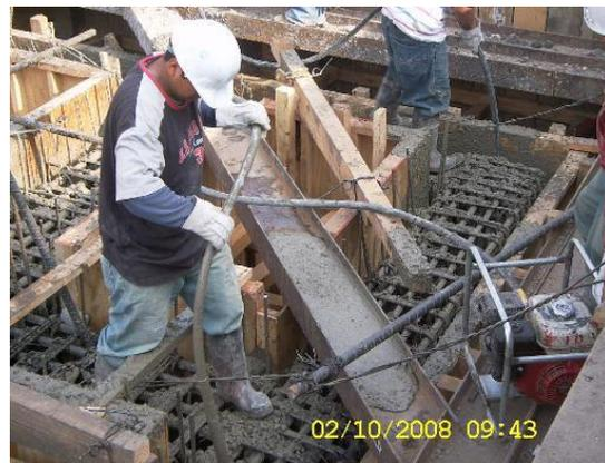
Vibrado del concreto para asegurar un acomodo adecuado del mismo.
