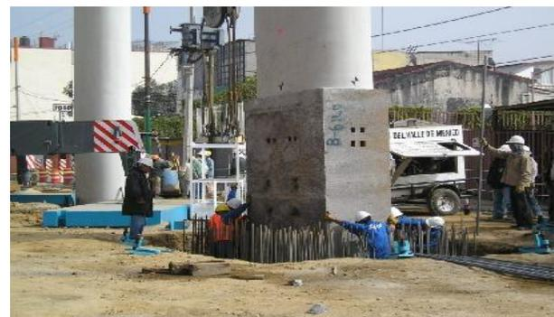
Se introduce la columna dentro de la zapata
