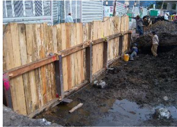
Colocación de tablonés en todo lo ancho y largo de la excavación
