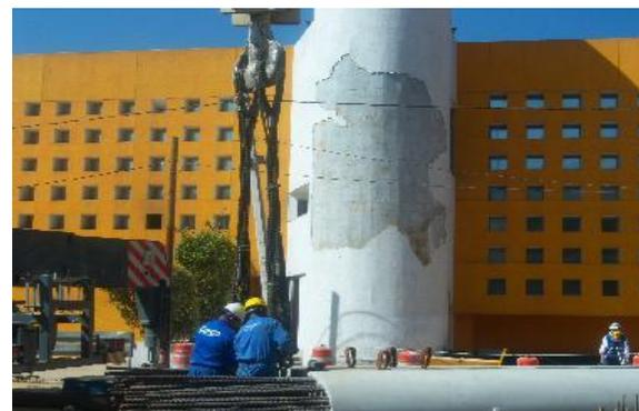
Colocación de los elementos de izaje (estrosos y grilletes) en la columna.
