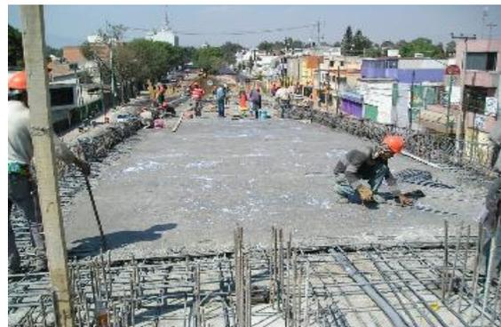
El concreto para el firme de compresión ocupa una resistencia de  $300 \text{ kg/cm}^2$
