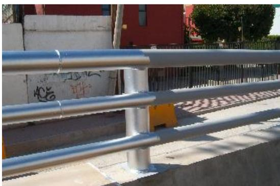
Sobre el primario anticorrosivo se aplica la pintura de esmalte color plateado
