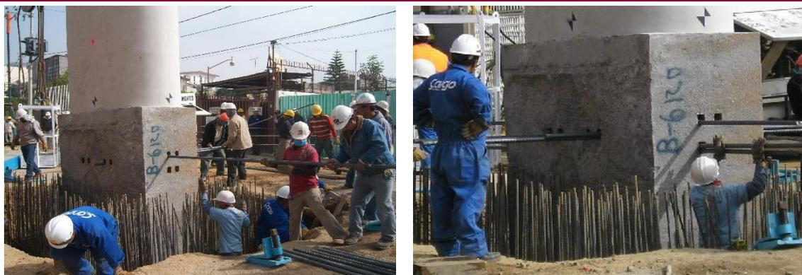
Colocación de las varillas de conexión dentro de los pasos ó ductos de conexión
