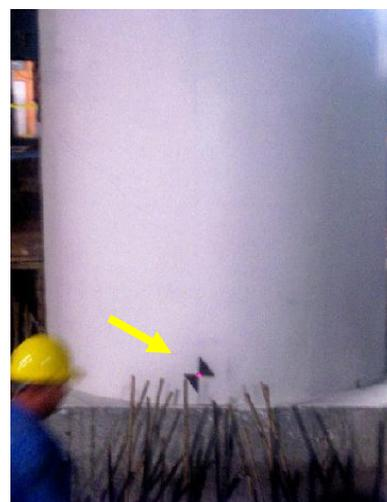
La brigada de topografía procede a verificar la alineación y nivelación de la columna
