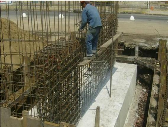
Armado del muro estribo con varilla del #4
