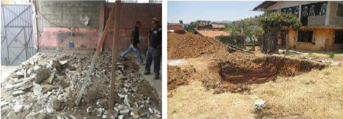
**Imagen 18.-** Retiro de materiales del sitio / retiro de capa orgánica después de cimentar.
