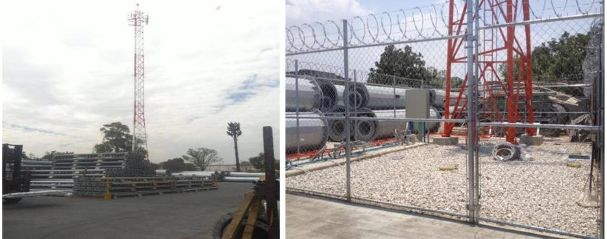
*Imagen 6.- Torre autosoportada con sección cónica hasta 18m y sección contante.*
