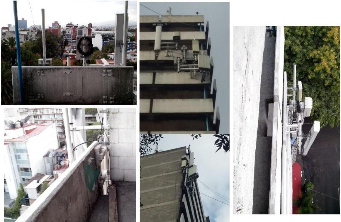
*Imagen 13.- Soportes para antenas directamente a pretil o estructura del edificio.
