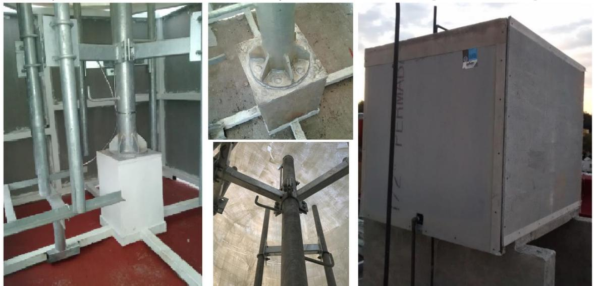
*Imagen 9.- Mástil de 3m sobre azotea, con camuflaje tipo tinaco.
