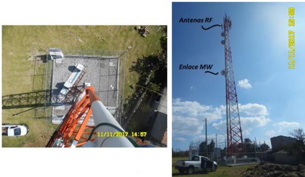
**Imagen 4.-** Sitio: LOS TORILES, foto de torre y foto de planta con equipos operando.
