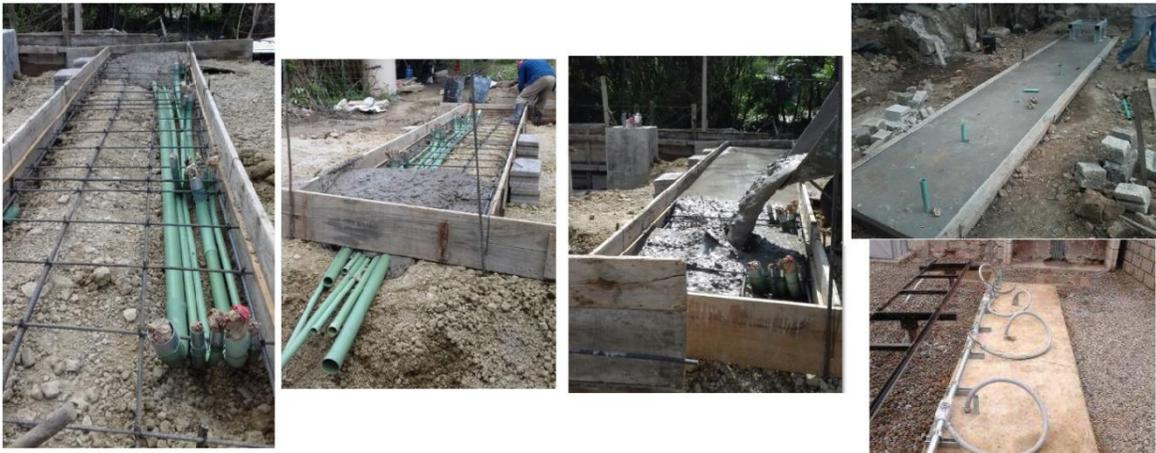
**Imagen 34.- Base de concreto para equipos (Gabinetes).**
