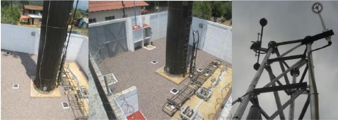
**Imagen 29.-** Cableado en torres del sistema de tierras.
