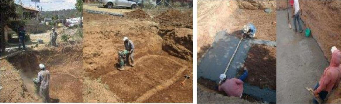
**Imagen 20.-** Compactación y nivelación de cimentación / firme de concreto en cimentación.
