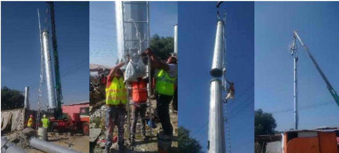
**Imagen 27.-** Montajes con grúa para monopolos.
