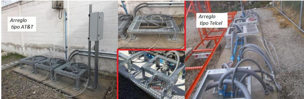
**Imagen 35.-** Base metálica para equipos (Gabinetes).
