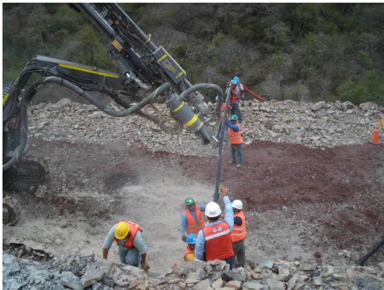
*Fotografía 8. Colocación de las anclas en el talud.*
