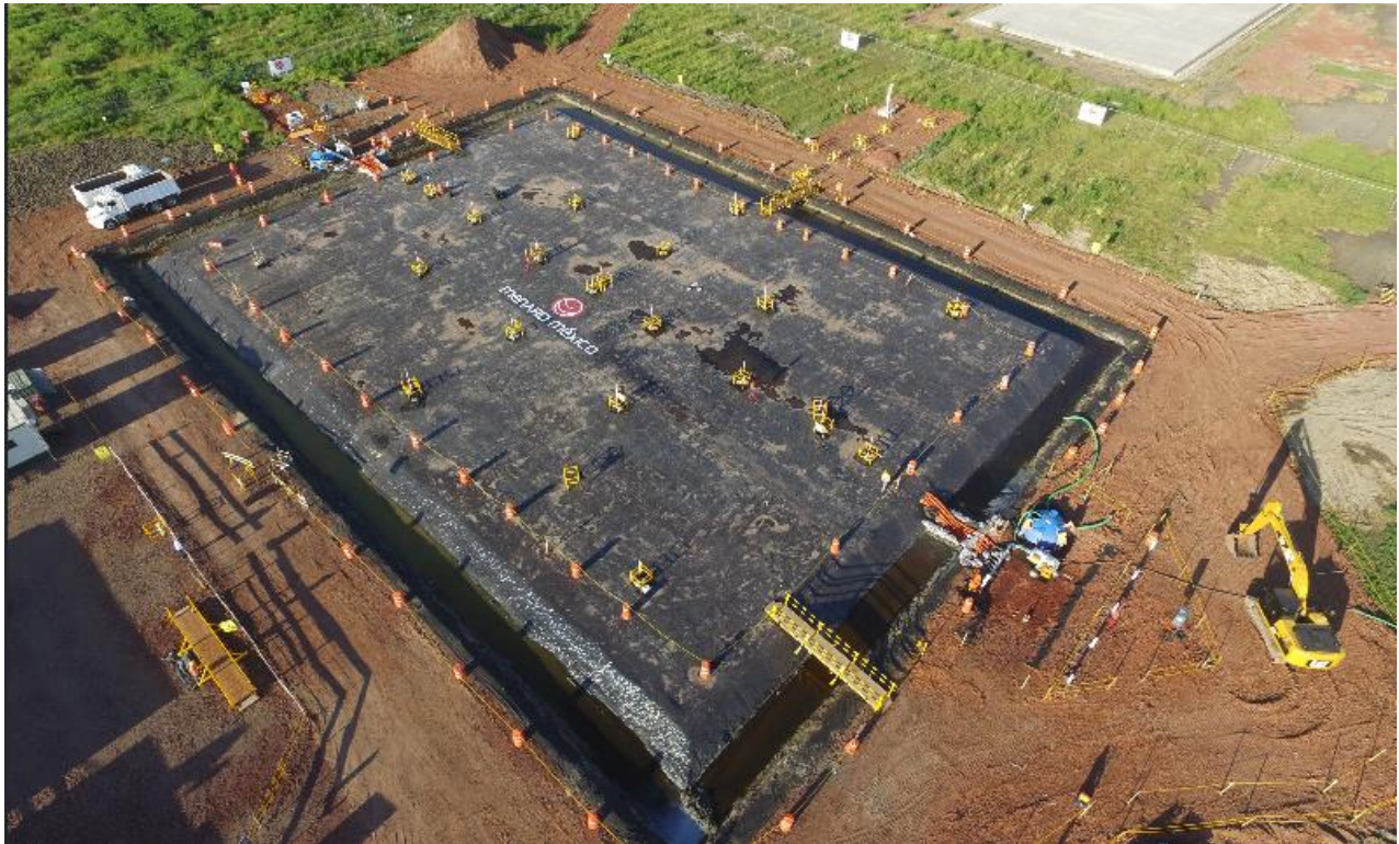
Figura 108.- “Foto aérea del panel de prueba del método de aceleración de la consolidación por vacío con membrana (Menard Vacuum)” Fuente: Menard México.
