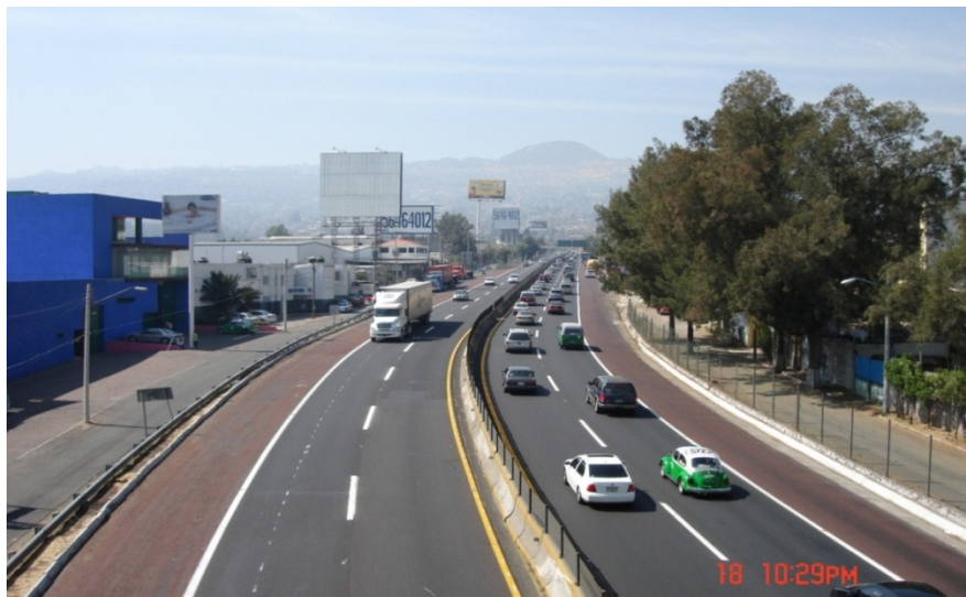
Panorámica del Corredor 2
