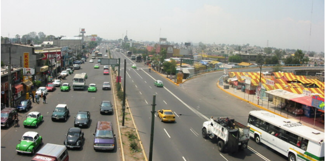
Panorámica del Corredor 24.
