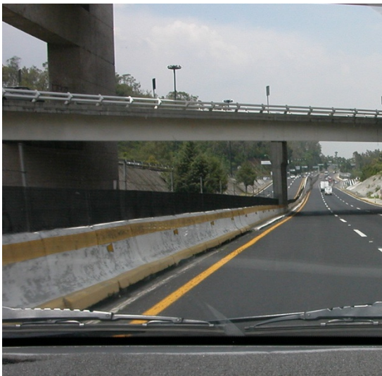
Vista del Corredor 5 a la altura de Valentín Gómez Farías.
