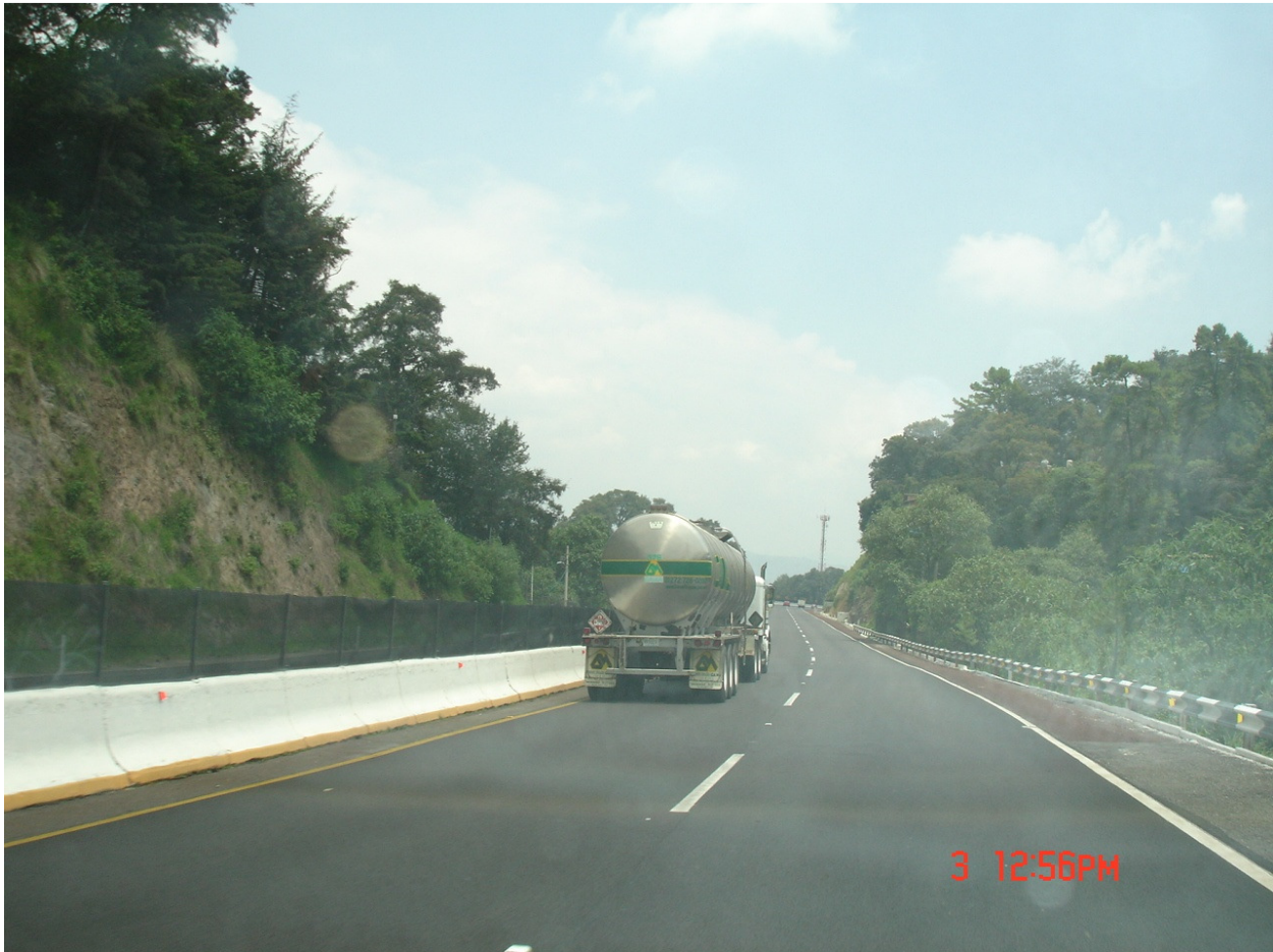
Fig. 2.7 Vista del Corredor 1.
