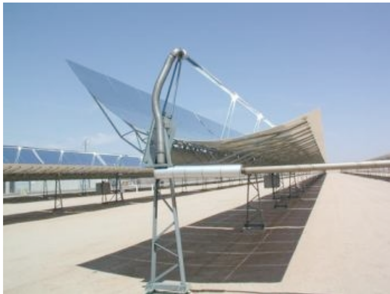
Figura 27. Estructura de un captador LUZ LS-3 (RenewableEnergyWorld,2009)
