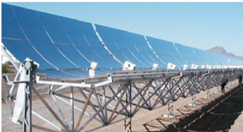
Figura 29, Estructura de un captador Solargenix (AEC, 2009)
