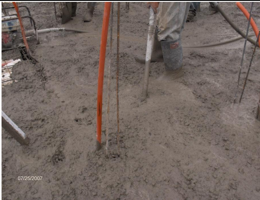
VIBRADO DE LOSA DE ENTREPISO DE SEGUNDO NIVEL
