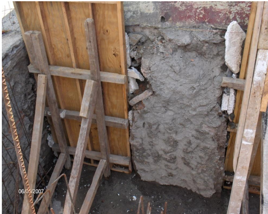
REFUERZO DE CIMENTACIÓN.
