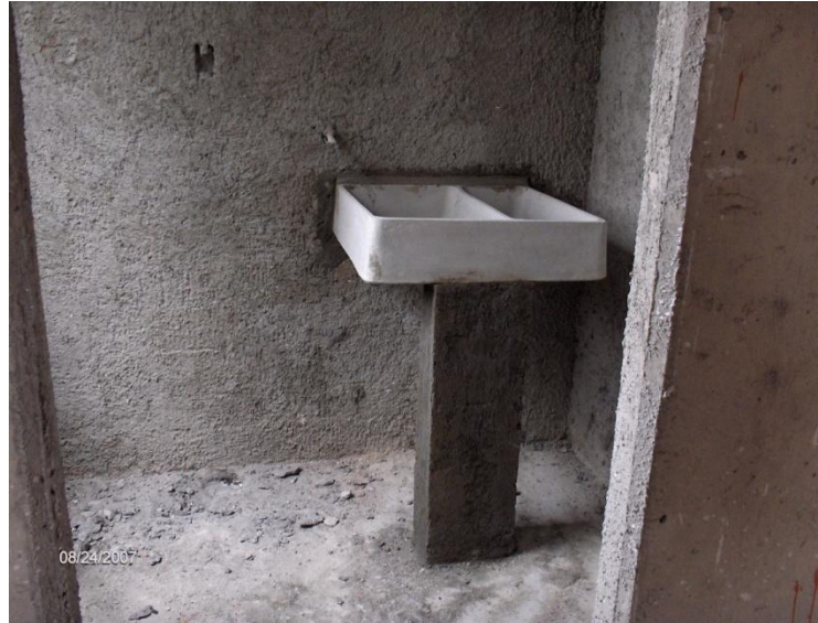
LAVADERO EN PATIO DE SERVICIO.
