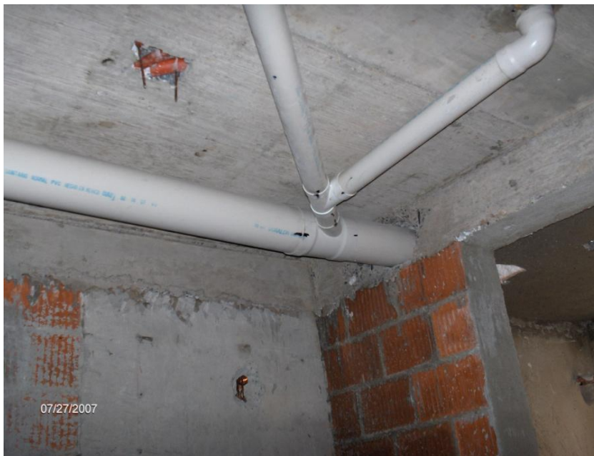
COLOCACION DE INSTALACION SANITARIA EN PLANTA BAJA
