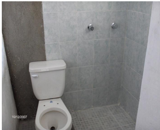
ACABADO EN BAÑO DE CASA HABITACIÓN.
