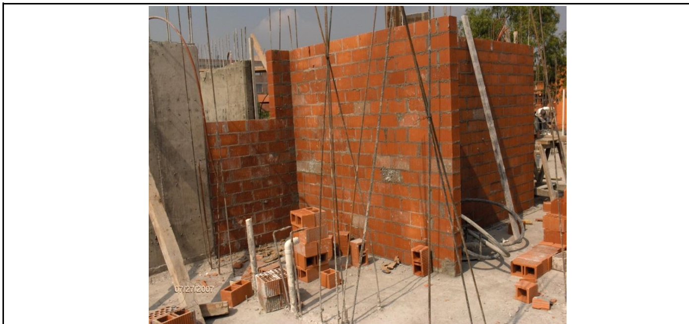
DESPLANTE DE MURO DE TABIQUE EN TERCER NIVEL
