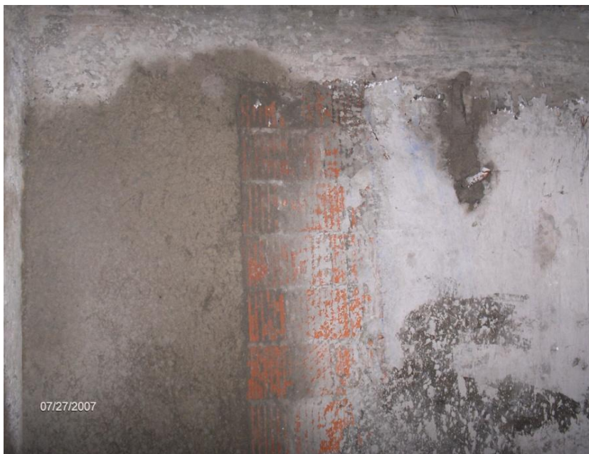
APLANADO DE MORTERO EN BAÑO DE DEPARTAMENTO DE PLANTA BAJA
