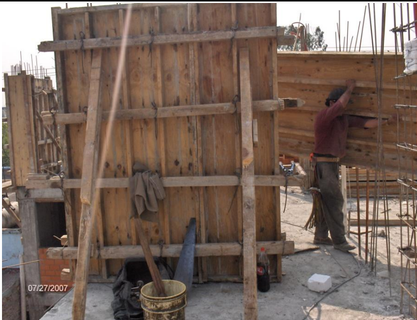
CIMBRADO DE MURO "M" EN TERCER NIVEL
