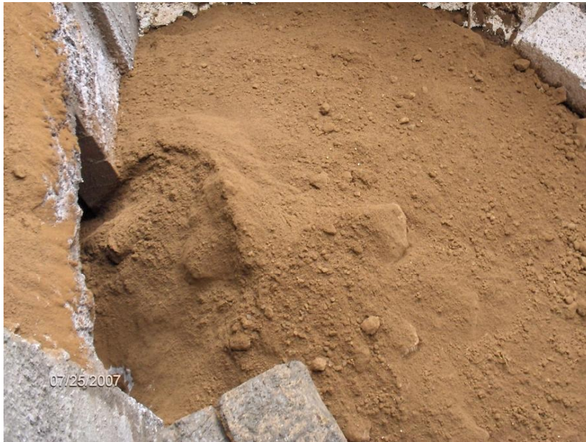
COLOCACION DE RELLENO EN ZONA DE LA CISTERNA
