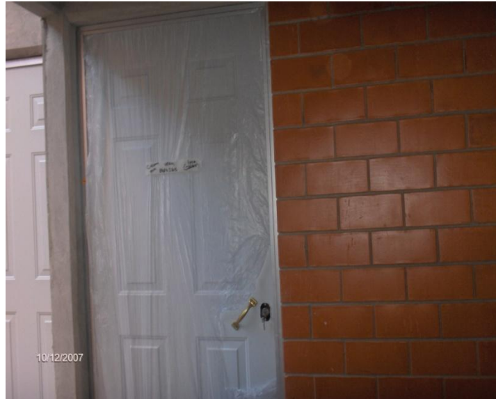
PUERTA DE ACCESO A VIVIENDA.
