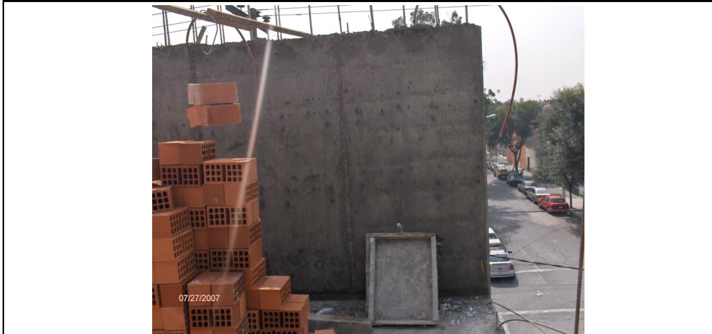
COLADO DE MURO "M" EN TERCER NIVEL.
