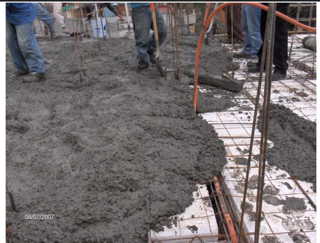
COLADO DE LOSA DE ENTREPISO DE TERCER NIVEL.
