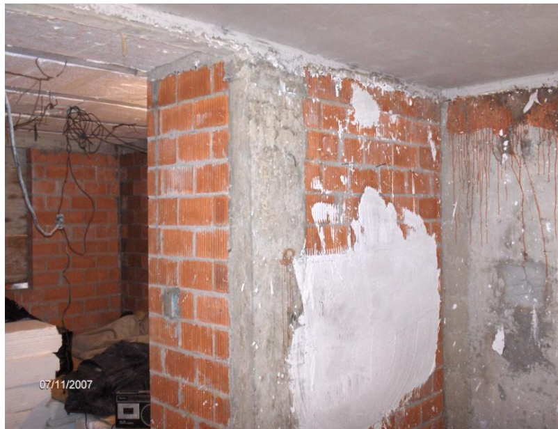
INICIO DE COLOCACION DE YESO EN DEPARTAMENTOS
