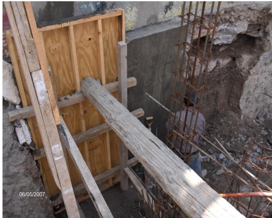
MURO DE CONCRETO PARA REFORZAR CIMENTACION DE BARDA DE COLINDANCIA.
