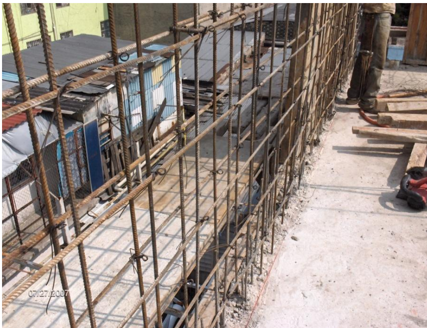
ARMADO DE MURO "M" EN TERCER NIVEL.
