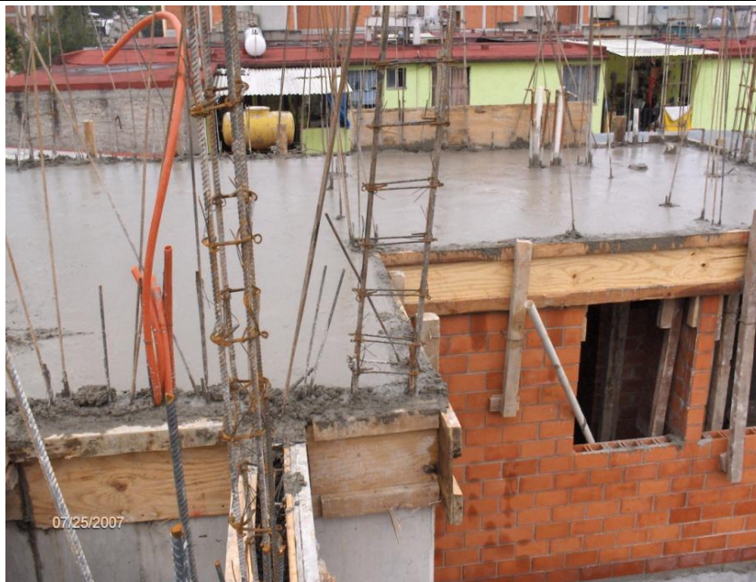
VIBRADO DE LOSA DE ENTREPISO DE SEGUNDO NIVEL
