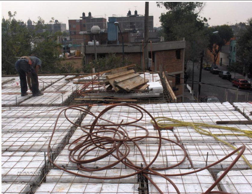
COLOCACION DE MALLA PARA LOSA DE ENTREPISO.
