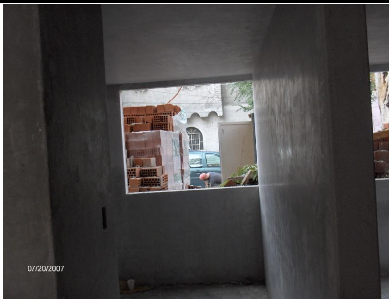
COLOCACION DE YESO EN RECAMARA DE DEPARTAMENTO DE PLANTA BAJA
