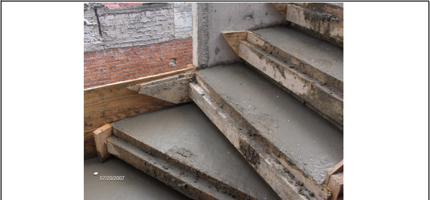
COLADO DE ESCALERA DE ENTREPISO DEL SEGUNDO NIVEL
