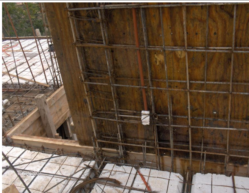
ARMADO DE MURO "M" EN TERCER NIVEL.
