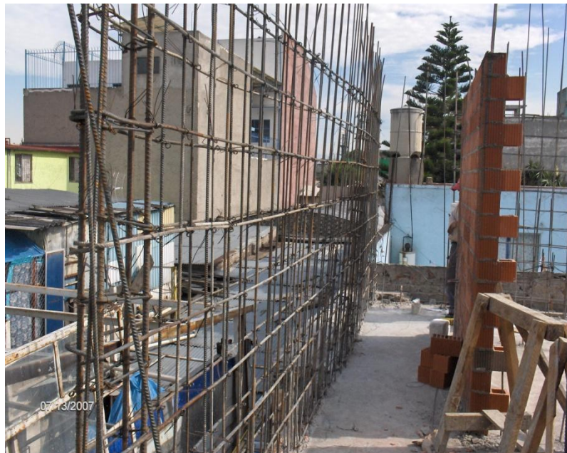
ARMADO DE MURO M-1, UBICADO EN EL EJE A.
