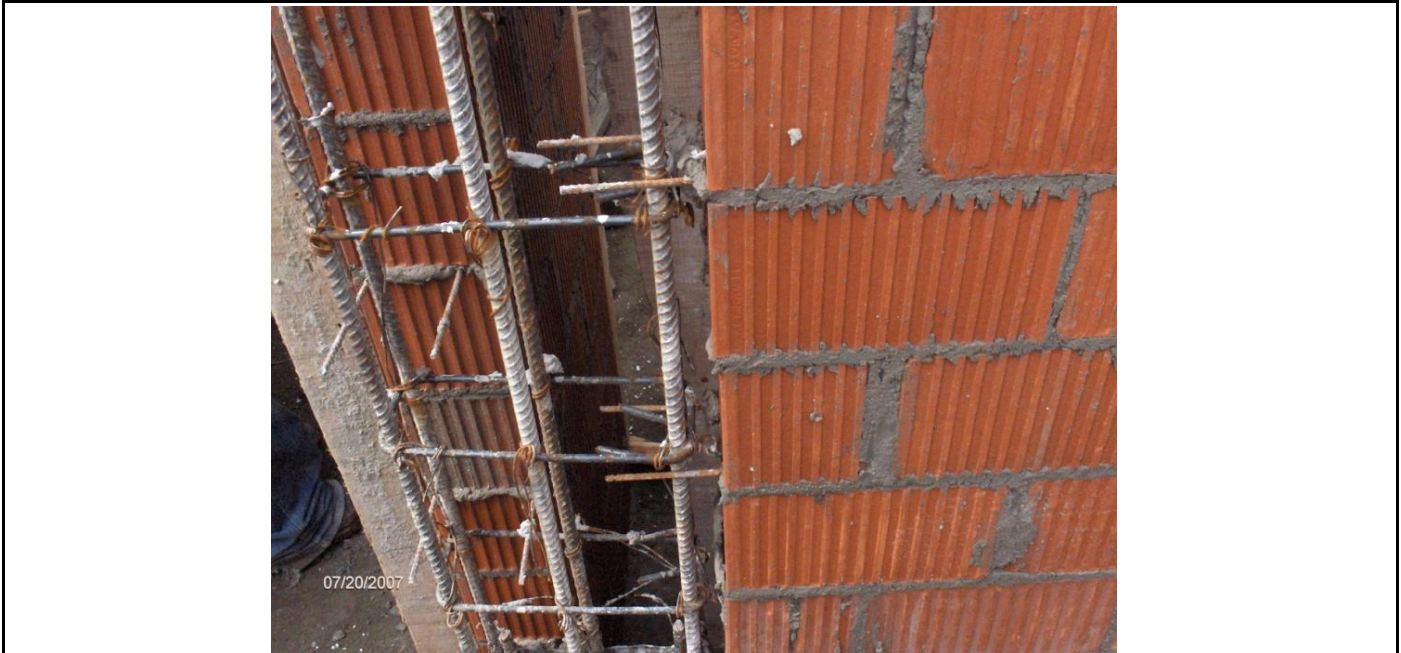
COLOCACION DE ACERO DE REFUERZO TEC 60 EN MUROS
