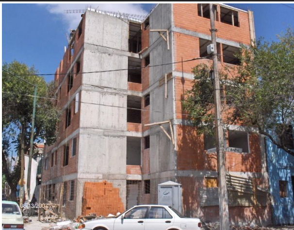
VISTA DEL ESTADO ACTUAL DE LA OBRA
