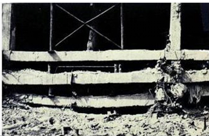
Destrucción total de columnas por flexo compresión.
