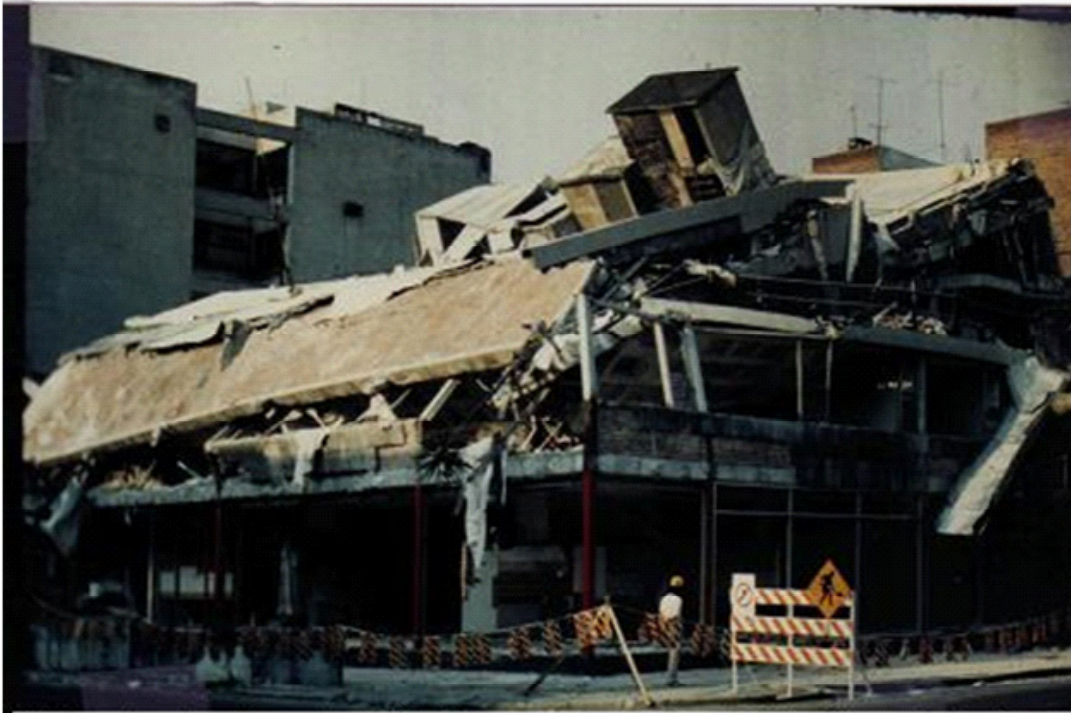
Falla estructural por torsión. Permanece núcleo rígido Altura 7 niveles. Destrucción parcial de estructura por falla de columnas en choque.
