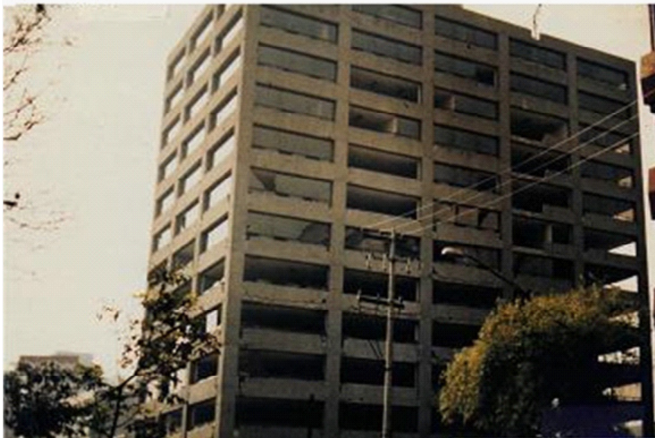
Edificaciones aparentemente sanas debieron ser reforzadas en nudos
