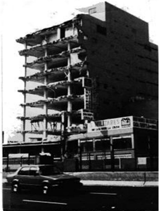
Dstrucción por torsión en los marcos exteriores de una estructura de 10 niveles con núcleo rígido excéntrico. Amplio espacio al frente
