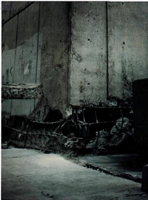
Estructura resistente. Falla al cortante del suelo
