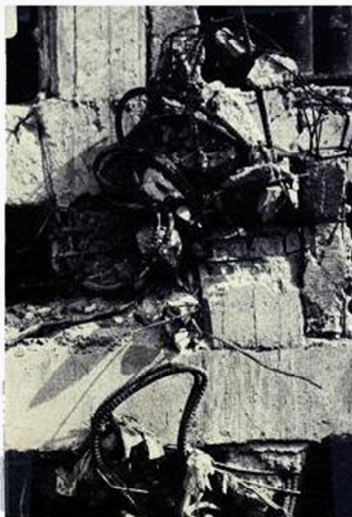
Destrucción total de columnas por flexo compresión.
