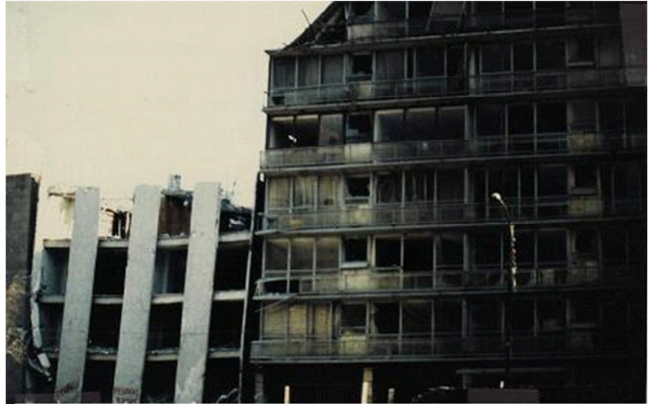
Choque entre edificios. Destrucción importante en marcos colindantes
