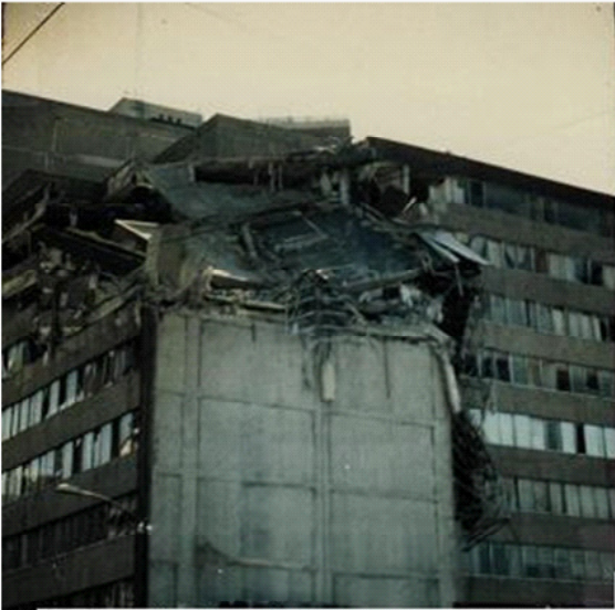
Destrucción de columnas en marcos extremos de edificios asimétricos
