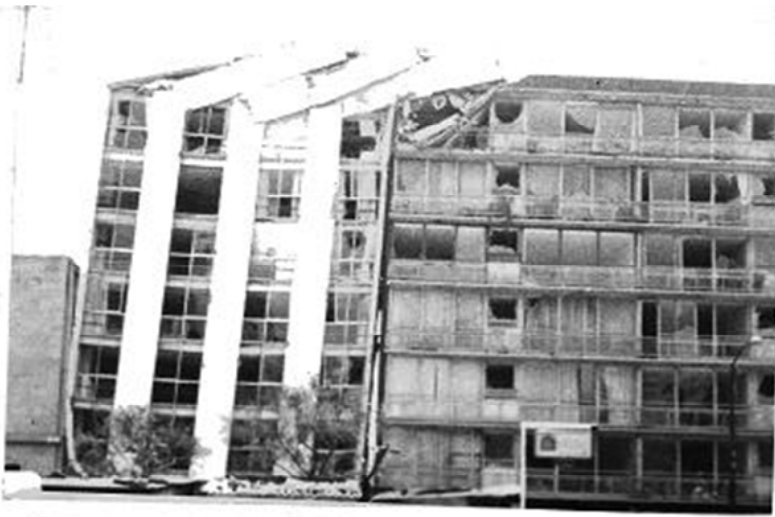
Clara destrucción pisos superiores del edificio alto 9 en choque con 6.
