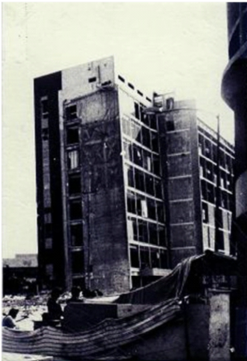
Fallas de suelo. Afectación parcial a estructura
