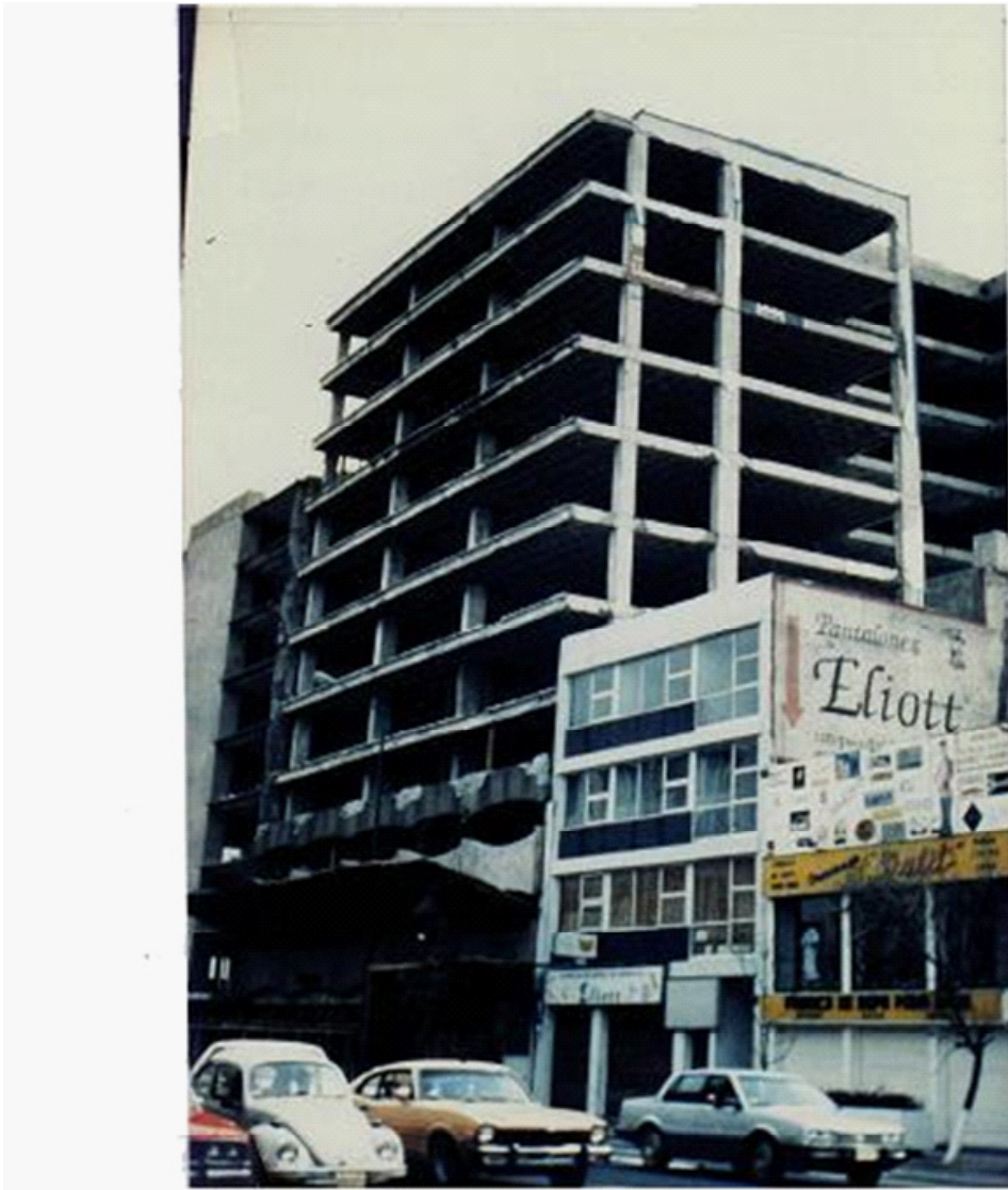
Edificaciones aparentemente sanas debieron ser reforzadas en nudos
