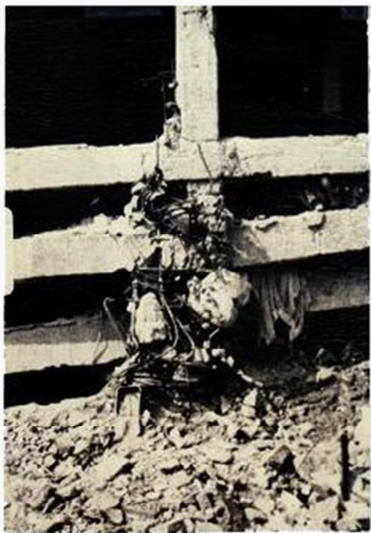
Destrucción total de columnas por flexo compresión.
