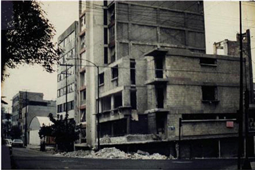
Estructura resistente. Falla al cortante del suelo
