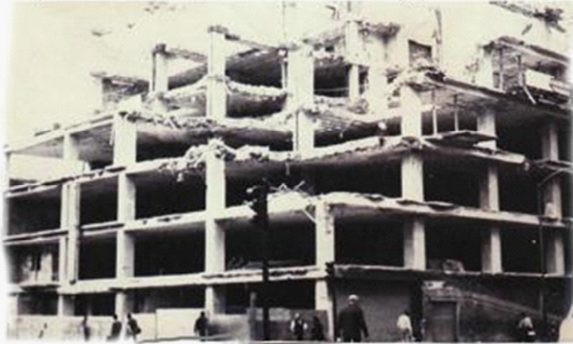
Clapso por torsión 5 pisos superiores. Núcleo servicios excéntrico 10 pisos Reestructuración del edificio y puesta en operación. Con 6
