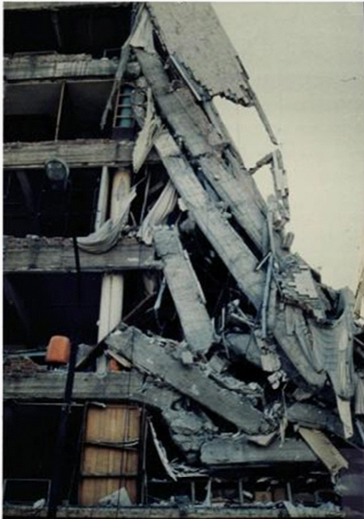
Falla estructural por torsión. Permanece núcleo rígido Altura 7 niveles. Destrucción parcial de estructura por falla de columnas en choque.
