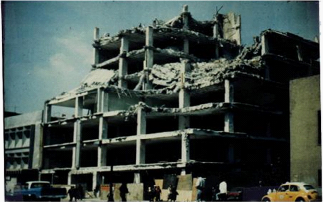
Clapso por torsión 5 pisos superiores. Núcleo servicios excéntrico 10 pisos Reestructuración del edificio y puesta en operación. Con 6
