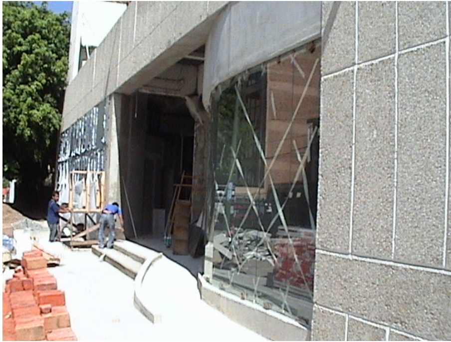
Figura 5.3 Acceso al Módulo de Atención Integral al Contribuyente Fachada Av. Filadelfia
