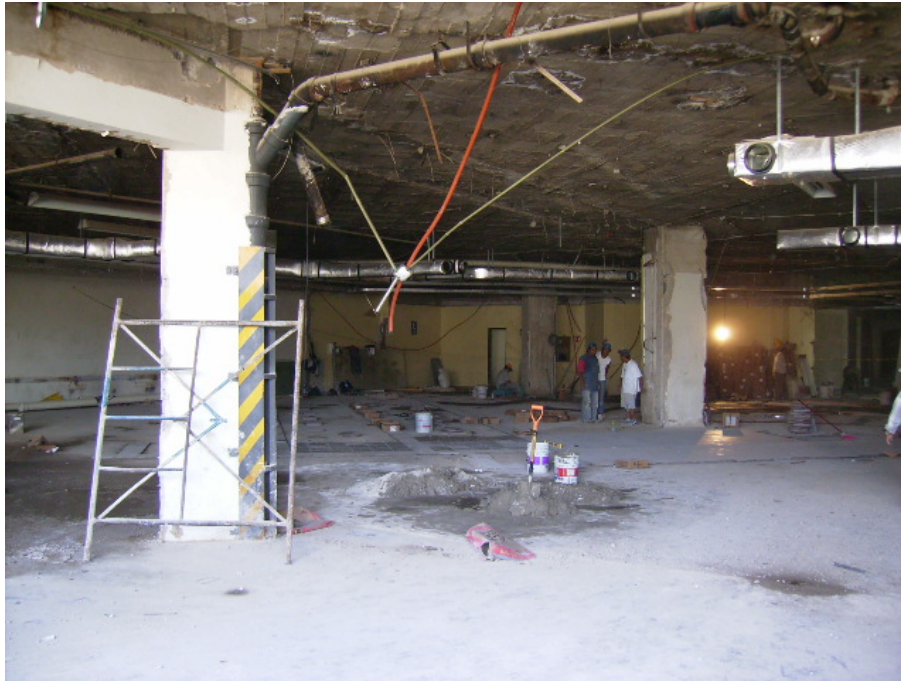
Figura 5.1 Proceso de Demoliciones en área del Módulo de Atención al Contribuyente
