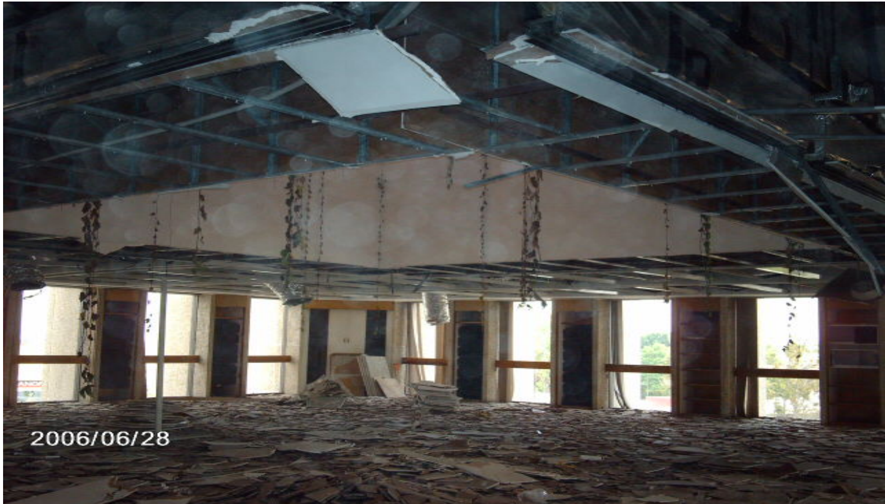
Figura 3.1. Trabajos de demoliciones en torre de oficinas.
