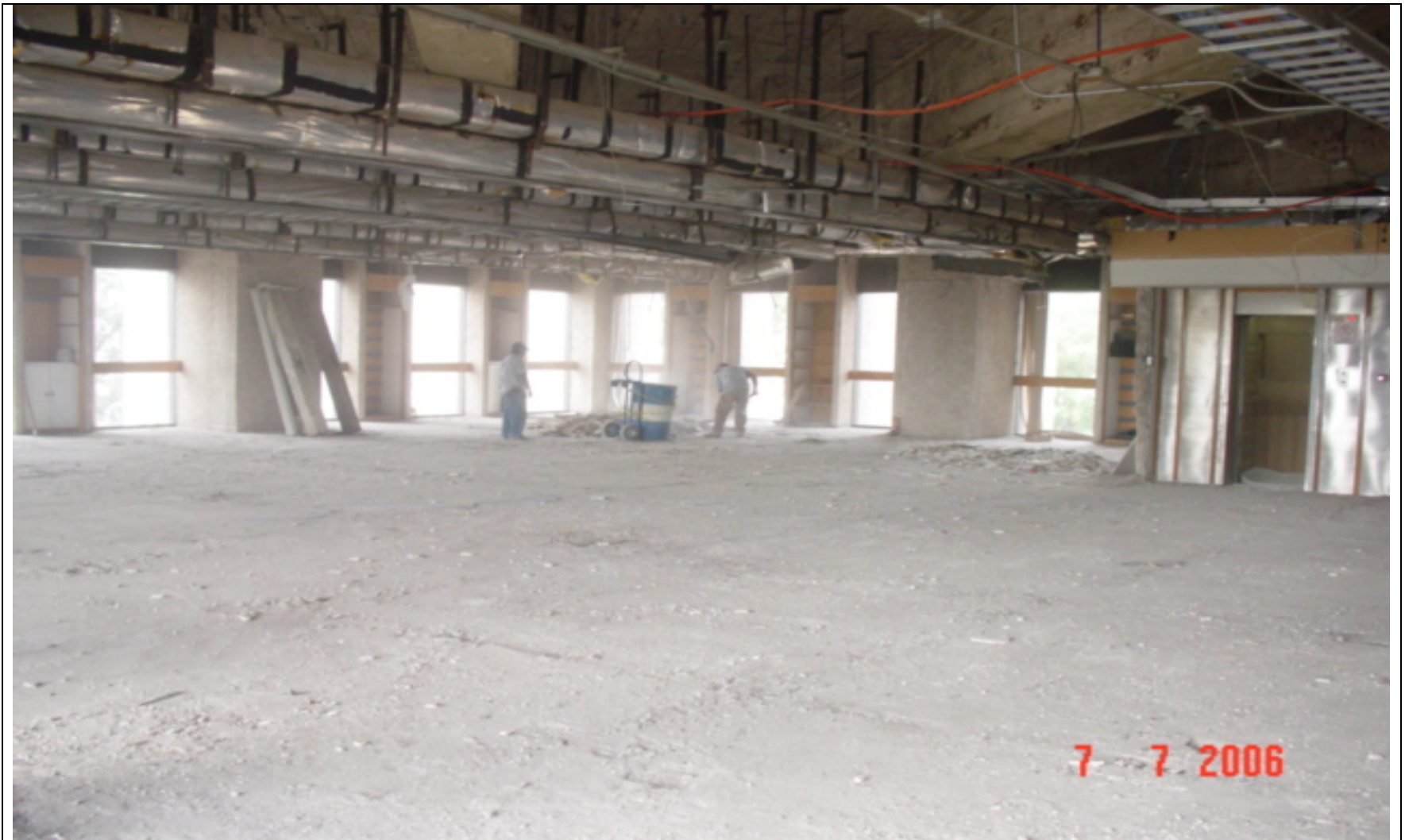
3.2. Área libre de escombros y preparada para la colocación de losetas cerámicas
