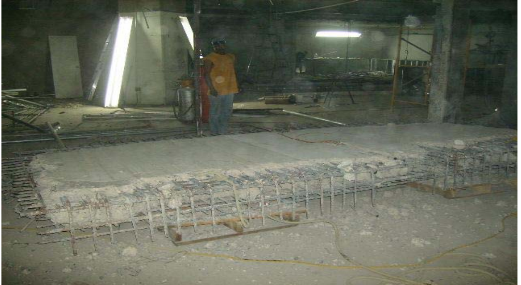
Figura 3.4. Espacio de bóveda abierto
