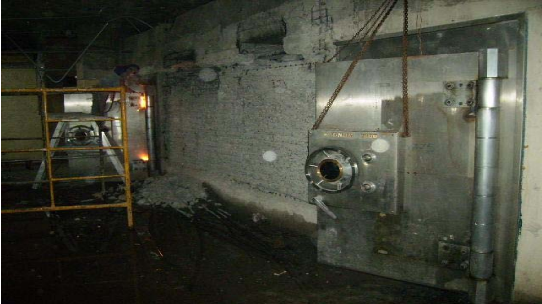
Figura 3.3. Demolición de muro para bóveda de alta seguridad
