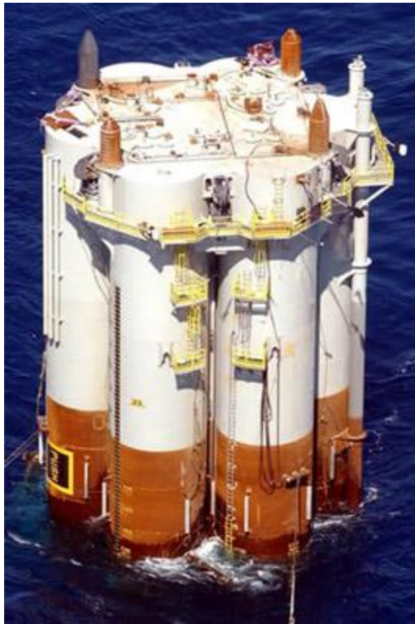
Figura I.14. Casco de flotación de una plataforma tipo Spar Cell (Fuente: www.offshore-technology.com )
