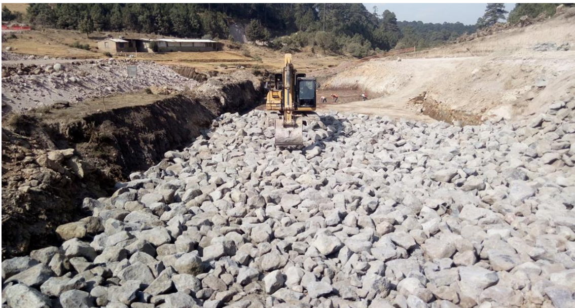
Ilustración 3 Mejoramiento de desplante de obra CAD 656+119.00.
