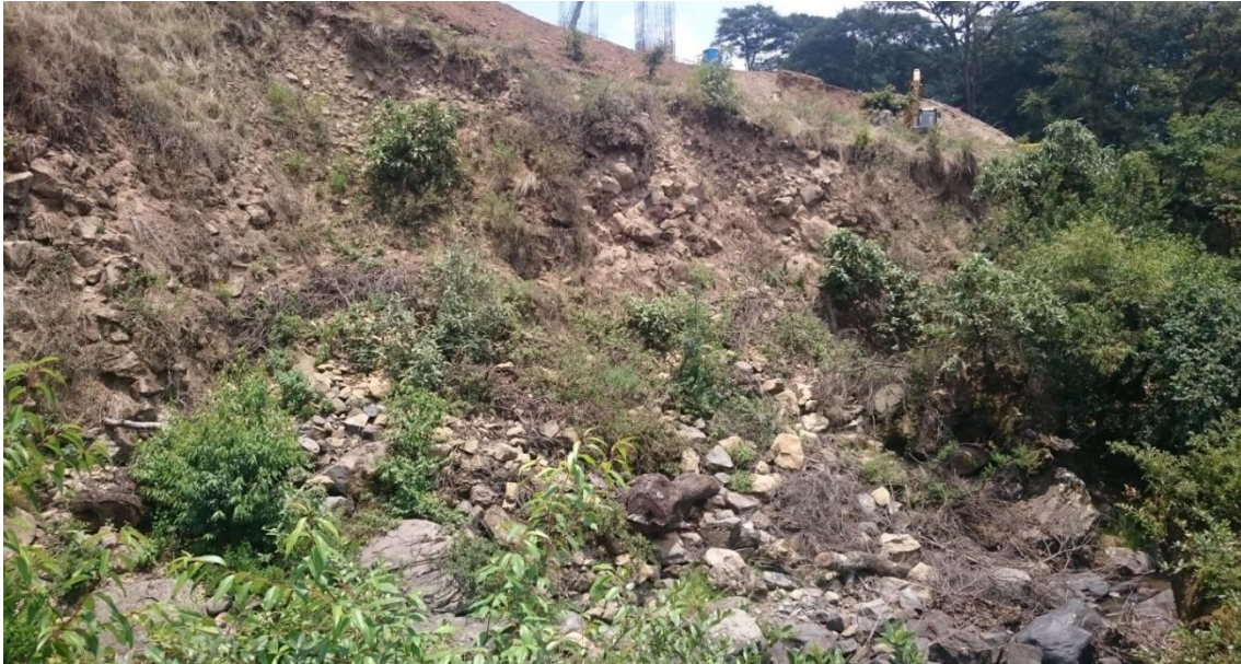
Ilustración 9 Material de pie de monte (suelo con roca fragmentada intercalada) en el talud aledaño al sitio del apoyo C4.
