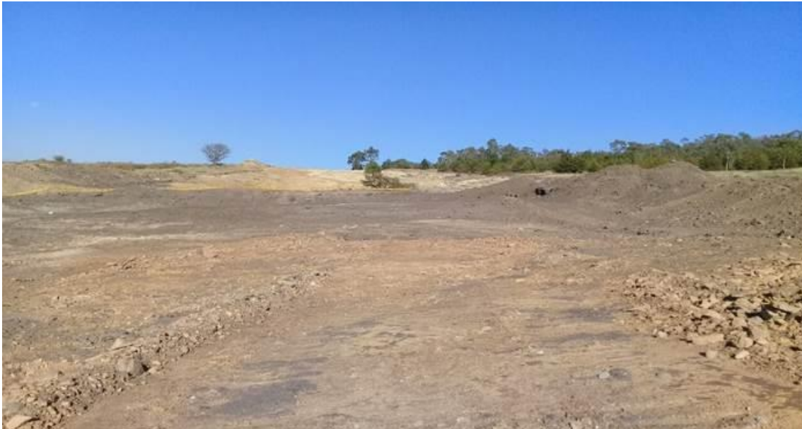
Ilustración 11 Zona de desplante de la obra de drenaje T3-AC-15E CAD 598+061.21 y 598+056.63.
