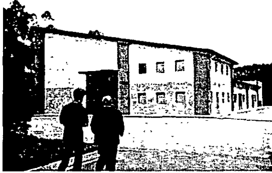
Planta de Generación con biogás en el Vertedero de Santander, España
