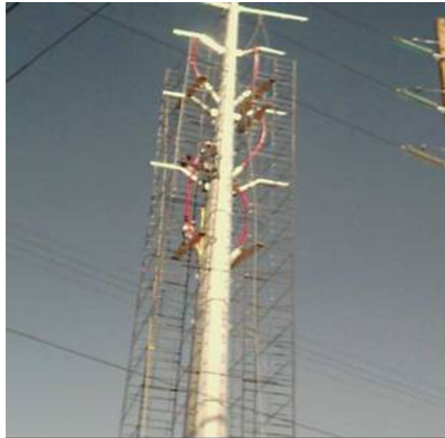
Figura 1-13 Transición de instalación subterránea a aérea.
