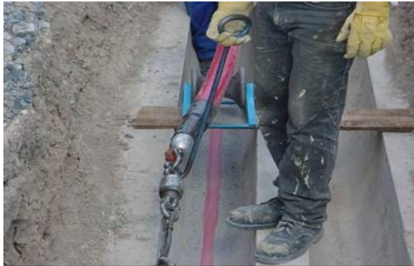
Figura 1-5 Instalación de cable con caletín.
