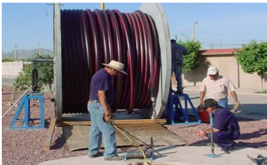
Figura 1-3 Preparativos para el tendido de conductor de alta tensión
