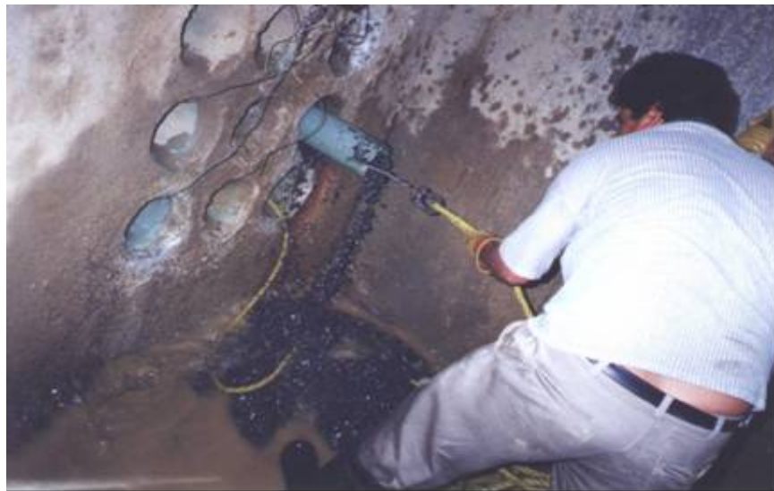
Figuras 1-12 Limpieza y purga de ductos cuando existe taponamiento
