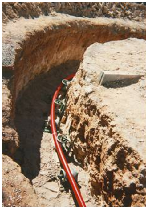
Figura 1-4 Tendido de conductor con ayuda de rodillos
