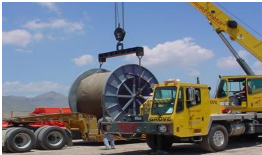
Figura 1-1 Transporte de una bobina de conductor de potencia.
