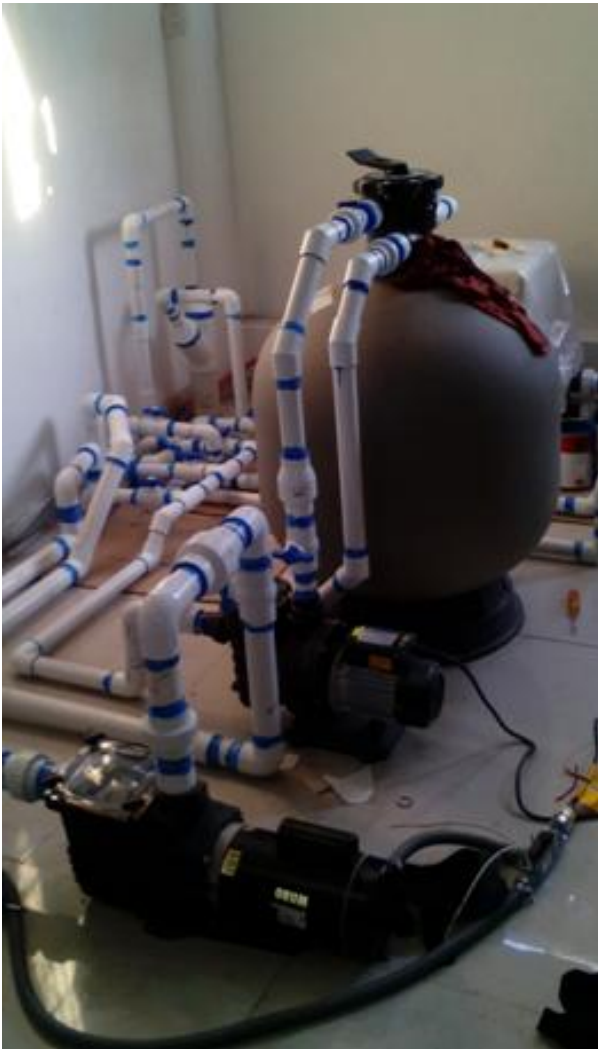
Fig. 46: Instalación en proceso.
