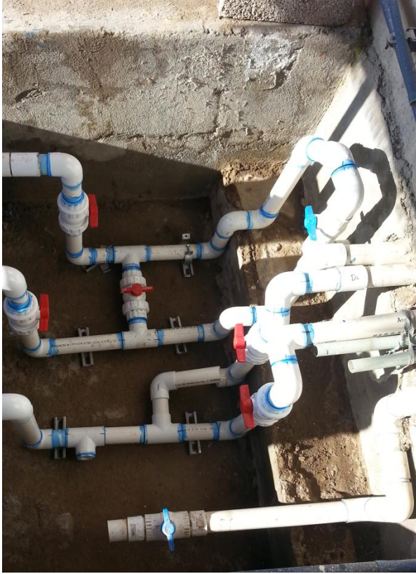
Fig. 29: Instalación de válvulas
