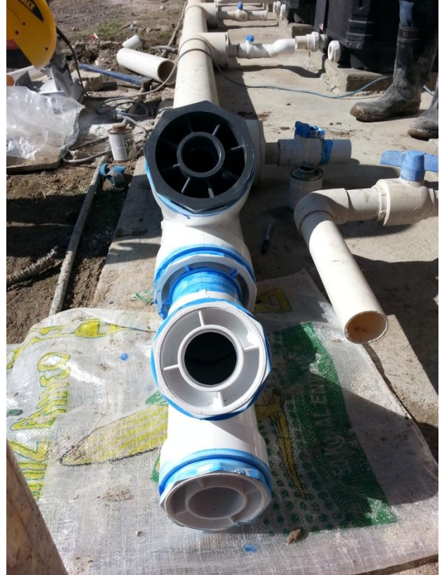
Fig. 30: Conexión tipo "Y" para filtros
