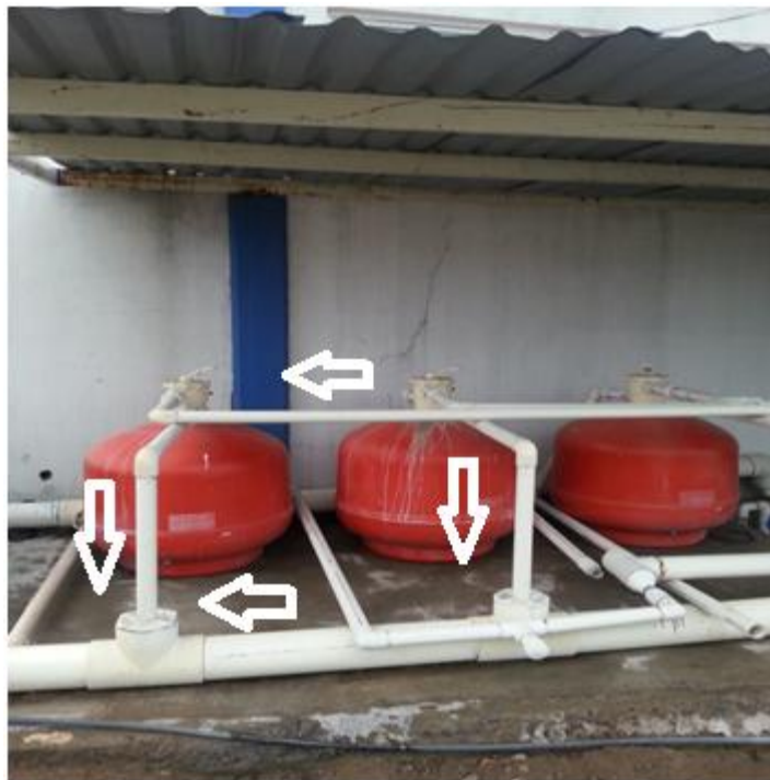
Fig. 25: Filtros de arena antes de modificar
