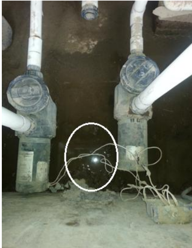
Fig. 26: motobombas preinstaladas
