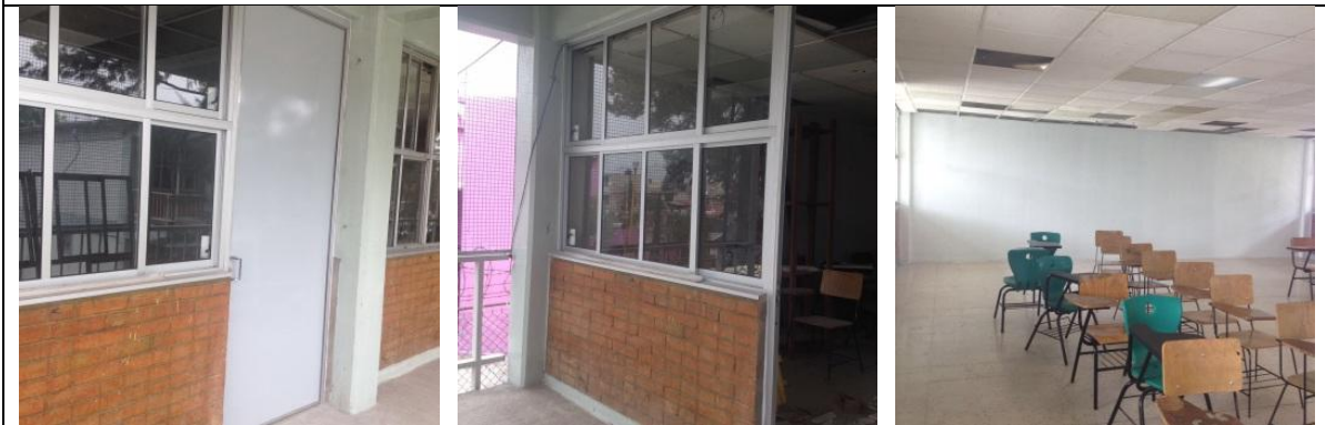
Adecuaciones en aula multidisciplinaria para construcción de modulo de Tutorias
