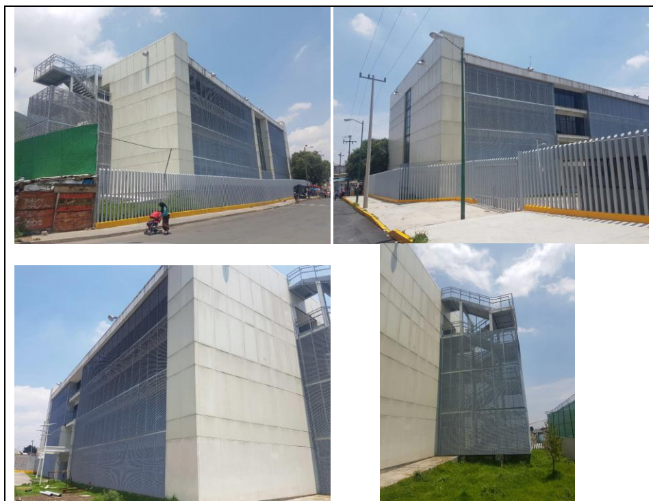
Imágenes: Reja de protección en fachadas del Instituto Tecnológico Iztapalapa II
