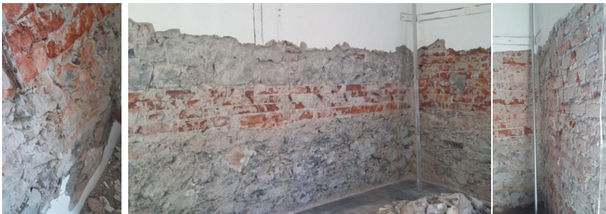
Demolición de aplanado existente de hasta 8 cm de espesor
