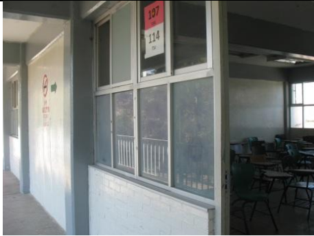
Cancelería de aulas
