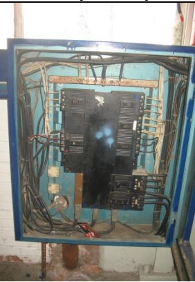
Subestación y tablero principal de distribución
