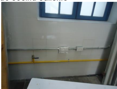
Bajada de instalación de hidráulica y gas al laboratorio de cocina caliente
