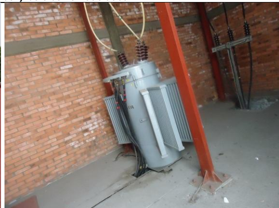
Mantenimiento a Subestación
