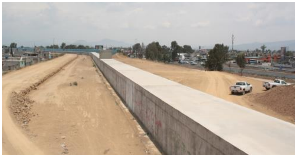
Figura 9. Colector sanitario Ducto de Estiaje y bordos retirados.
